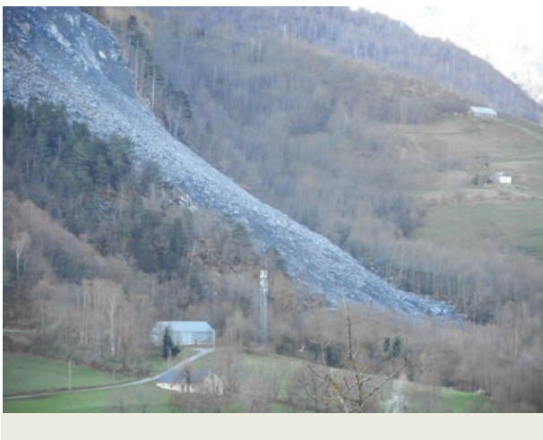
Glissement sur la commune de VIELLA (© RTM).
