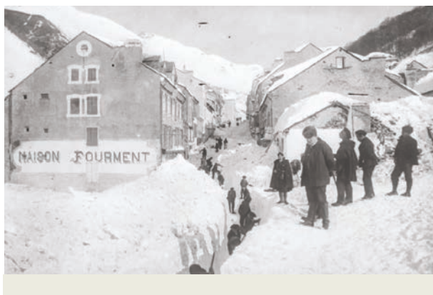
Avalanche 1907 - Barèges (© Archives départementales de la Haute-Garonne - Fonds Labouche)
