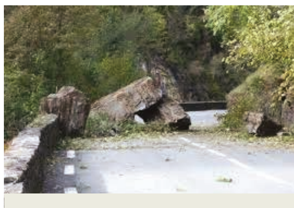
Eboulement chute de bloc - Gorges de Luz (© RTM).
