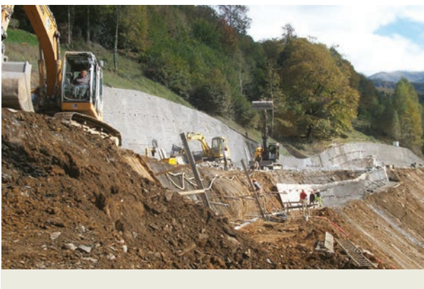
Mur soutènement Gazost (© RTM).
