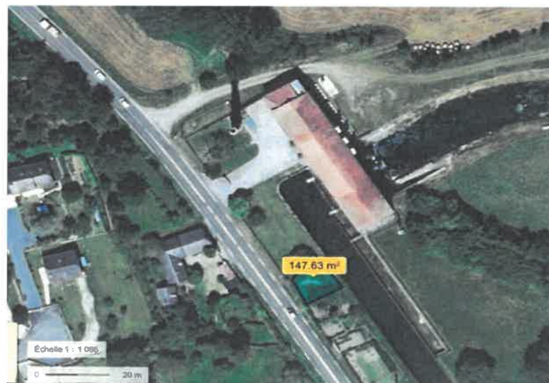
Figure 7: Zone des dépôts des gravats (phase aval)
