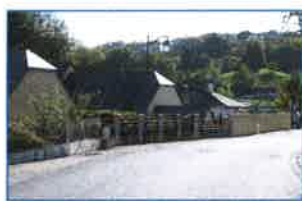
Pompe relevage route de Lourdes
