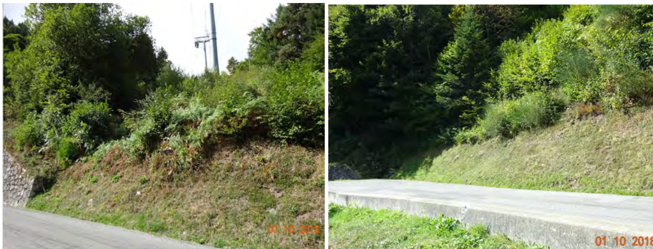
Photo n° 50 : Talus amont des deux traversées de route
