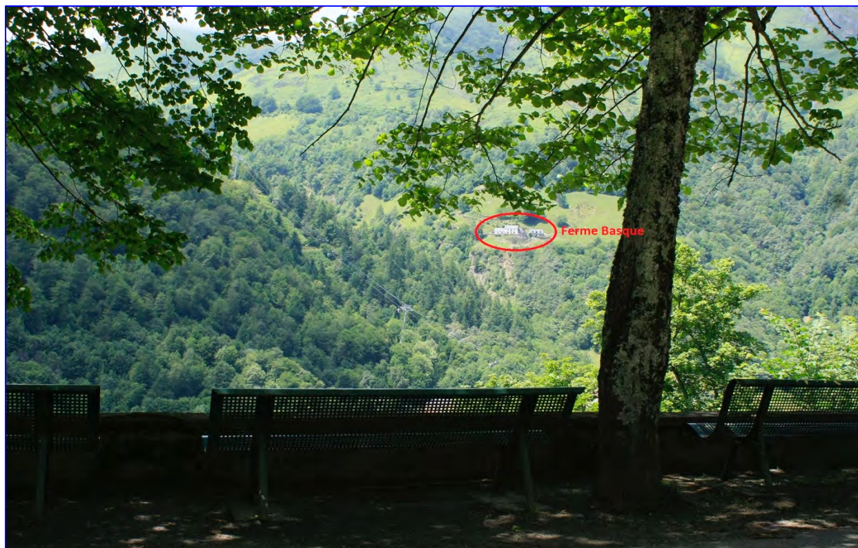
Photo n° 10 : Vue 6 - Vue depuis la terrasse des anciens Thermes de Pauze en direction de la vallée du Cambasque (date de prise de vue : 03/07/2017)
