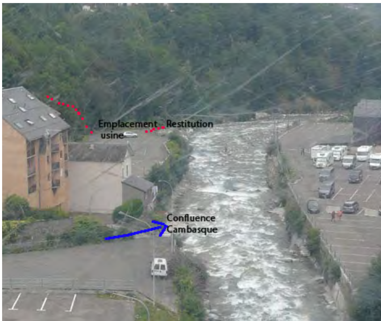
Photo n° 41 : Vue vers l'aval au niveau de la confluence des gaves du Cambasque et de Cauterets
