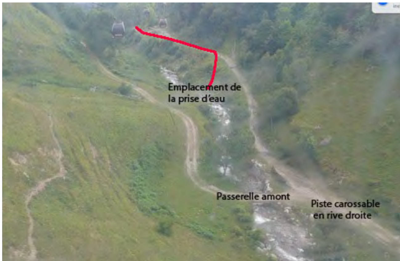
Photo n° 31 : Vue vers l'aval du secteur de la prise d'eau
