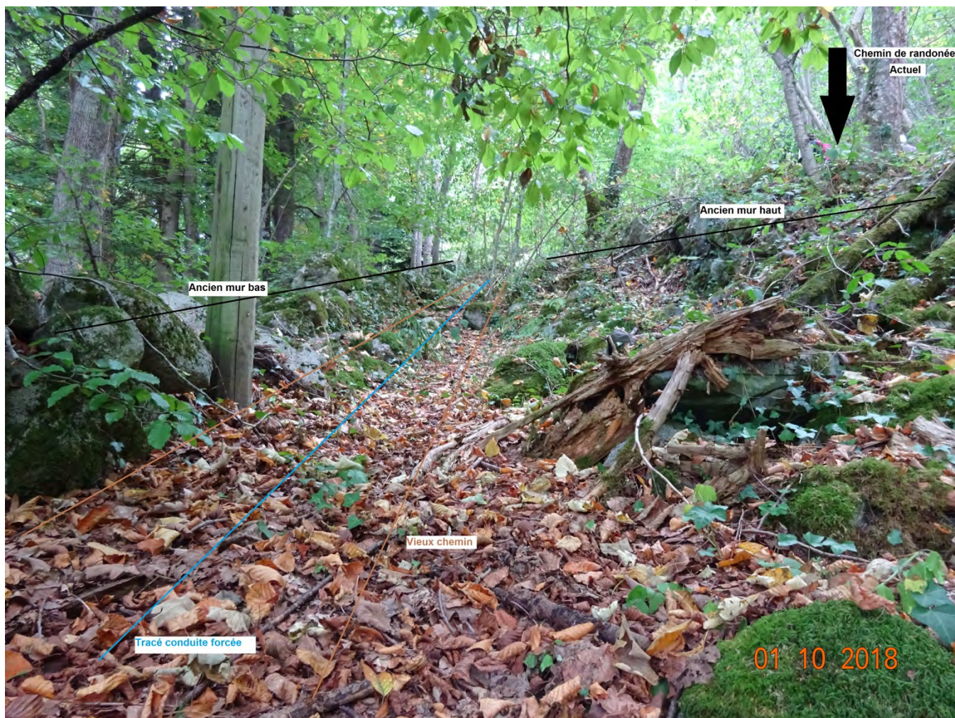
Photo n° 56 : État actuel muret pierre sèche et localisation passage conduite
