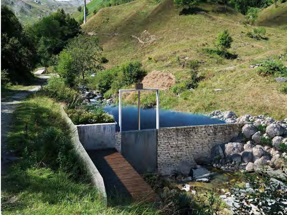
Photo n° 47 : Simulation prise d'eau - Vue vers l'amont
