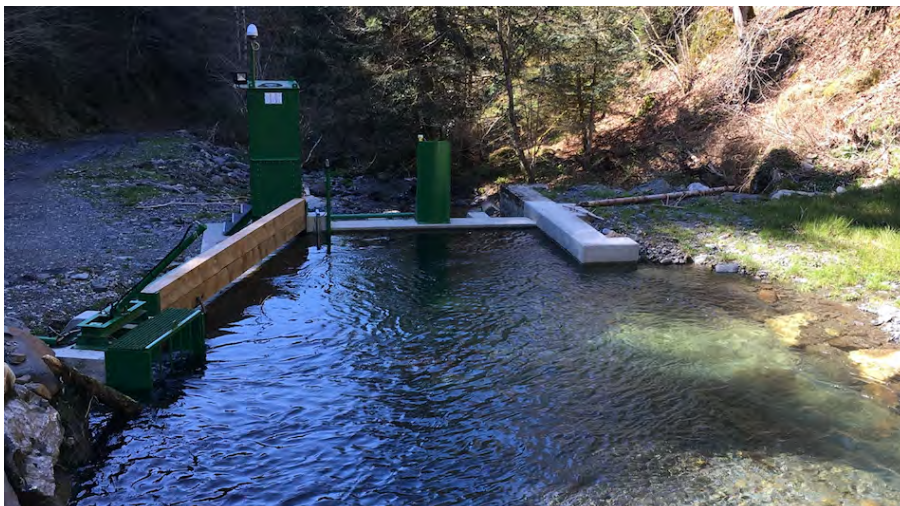
Photo n° 29 : Exemple de la prise d'eau de Gazost équipée d'une grille coanda et principe de fonctionnement
