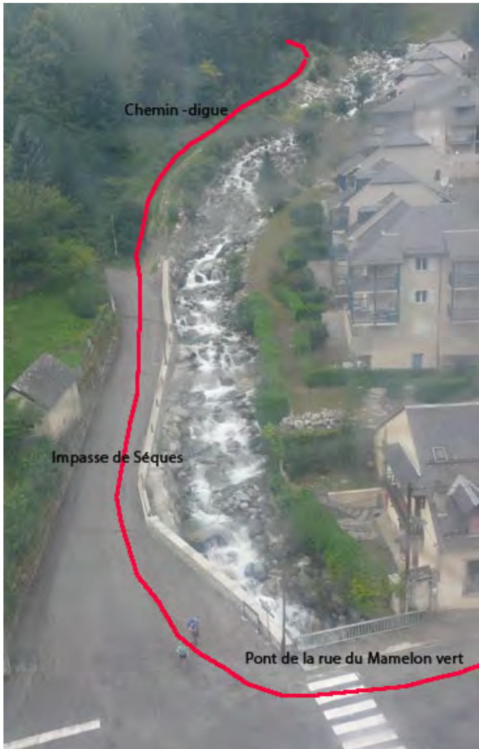
Photo n° 40 : Vue vers l'amont au niveau du pont de la rue du Mamelon vert
