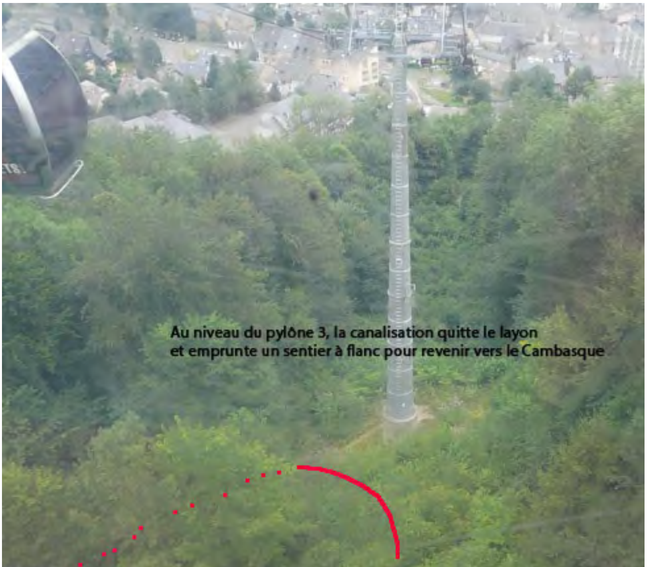
Photo n° 39 : Vue vers l'aval au niveau du pylône 3
