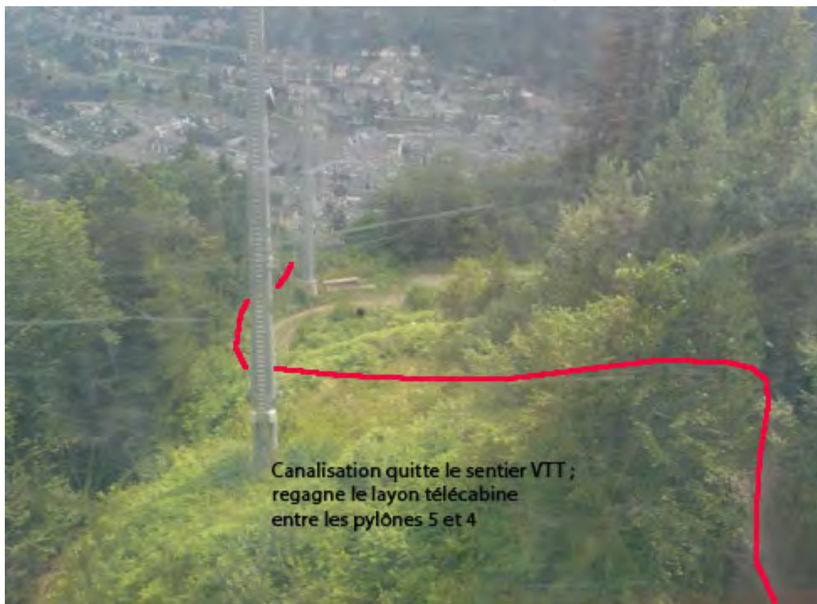
Photo n° 37 : Vue vers l'aval au niveau des pylônes 5 et 4
