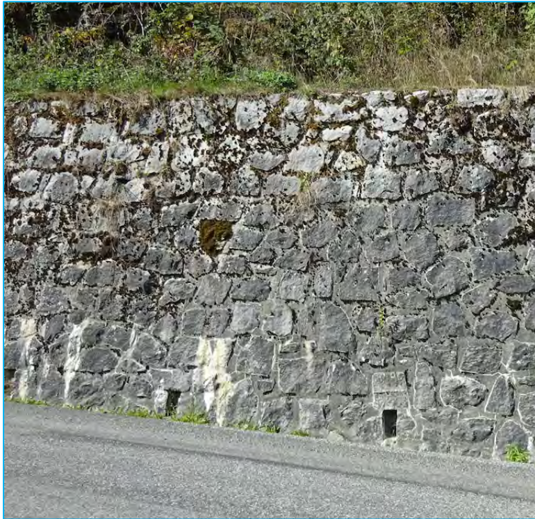
Photo n° 55 : Mur maçonné sur la route du Cambasque
