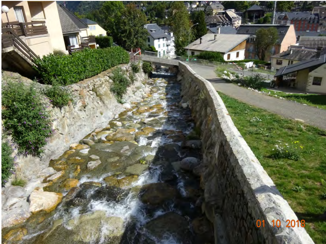
Photo n° 21 : Vue 17 - Cambasque vu vers l'aval depuis le pont de l'Avenue du Mamelon Vert (date de prise de vue : 01/10/2018)
