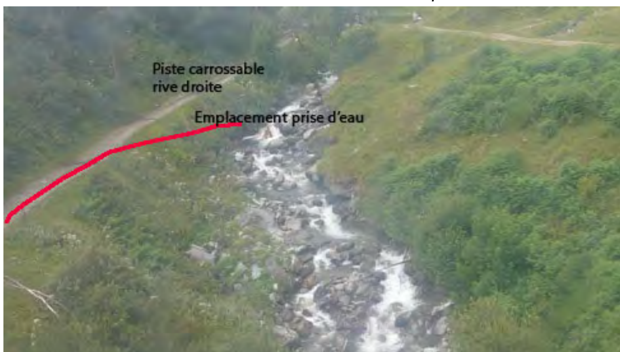
Photo n° 32 : Vue vers l'amont du secteur de la prise d'eau
