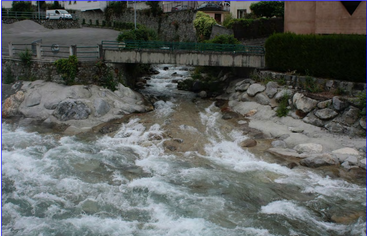
Photo n° 6 : Vue 2 - Confluence du Gave de Cambasque et du Gave de Cauterets vu depuis le parking de la Gare de Cauterets (date de prise de vue : 23/06/2017)
