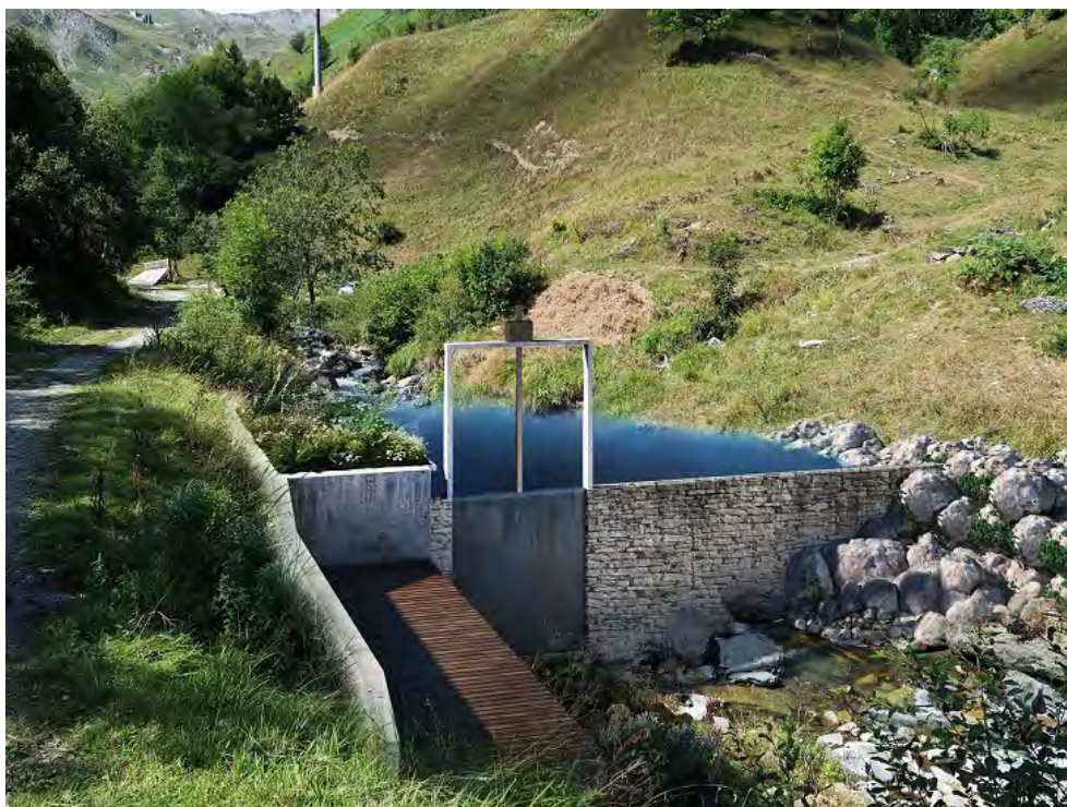
Photo n° 86 : Simulation prise d'eau - Vue vers l'amont
