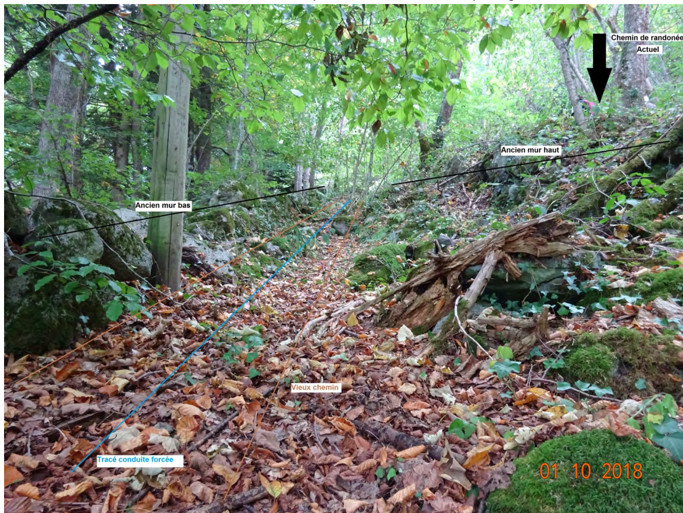
Photo n° 100 : État actuel muret pierre sèche et localisation passage conduite
