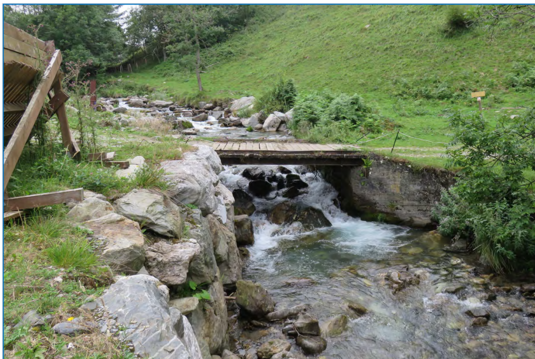
Photo n° 88 : Passerelle et équipement VTT en amont prise d'eau
