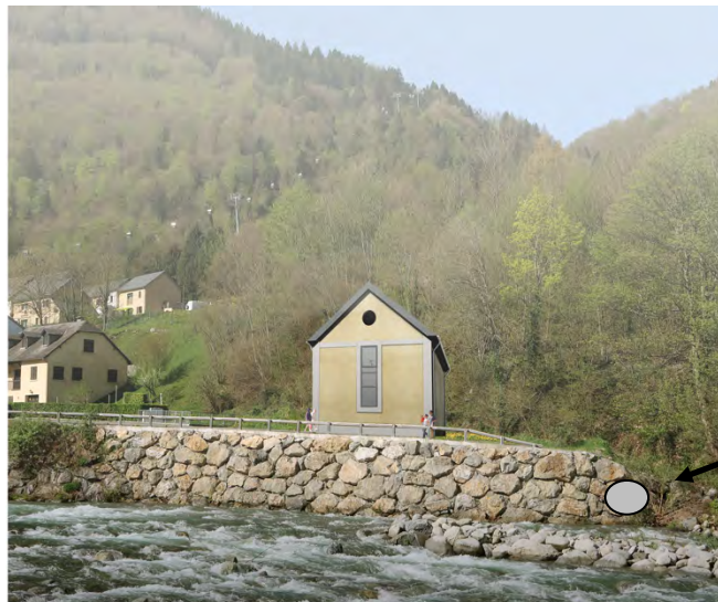
Photo n° 91 : Secteur de la restitution d'eau dans le Gave de Cauterets, vue depuis la rive droite
