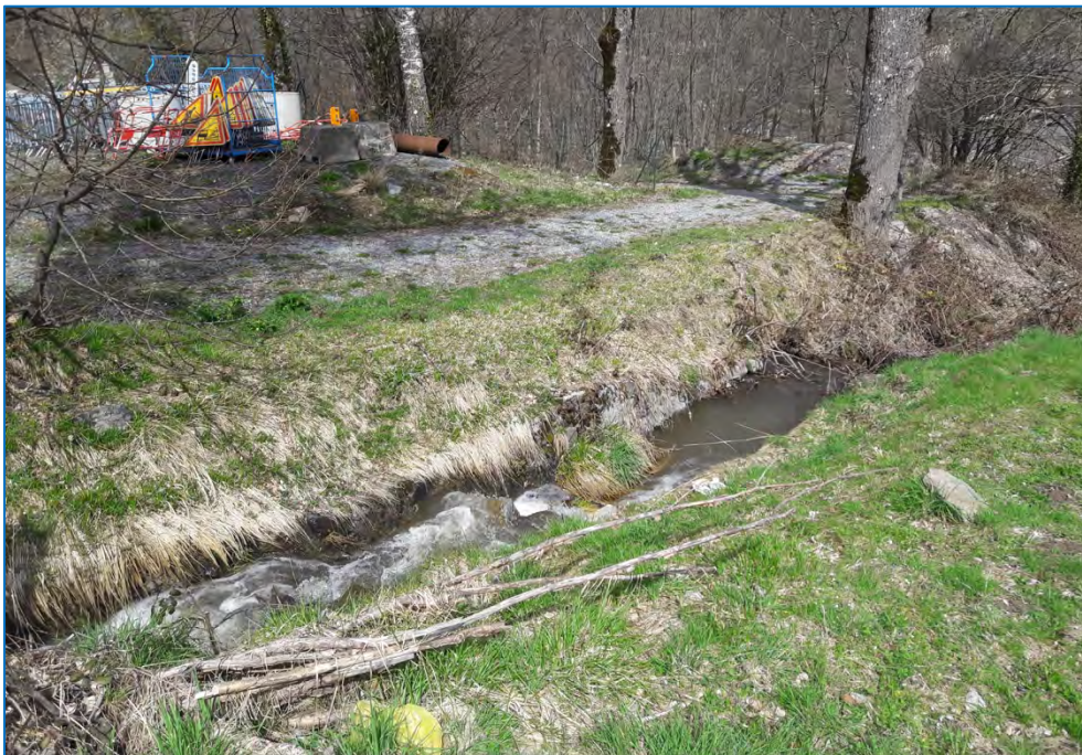
Photo n° 38 : Le ruisseau de Séques se jetant dans le gave de Cauterets près de la centrale hydroélectrique en projet
