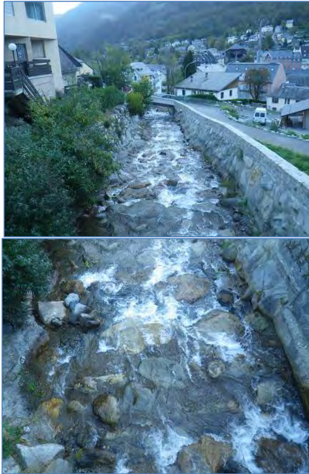
Source : © A. Desnos, SARL Pedon Environnement & Milieux Aquatiques, 2017
