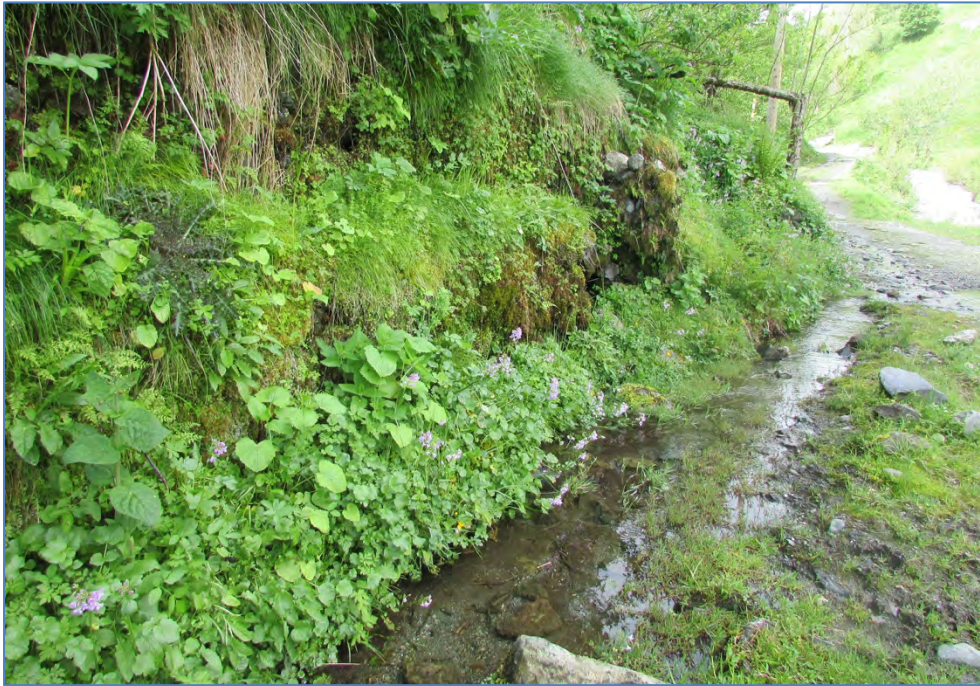
Photo n° 57 : Fossé en bas du talus
