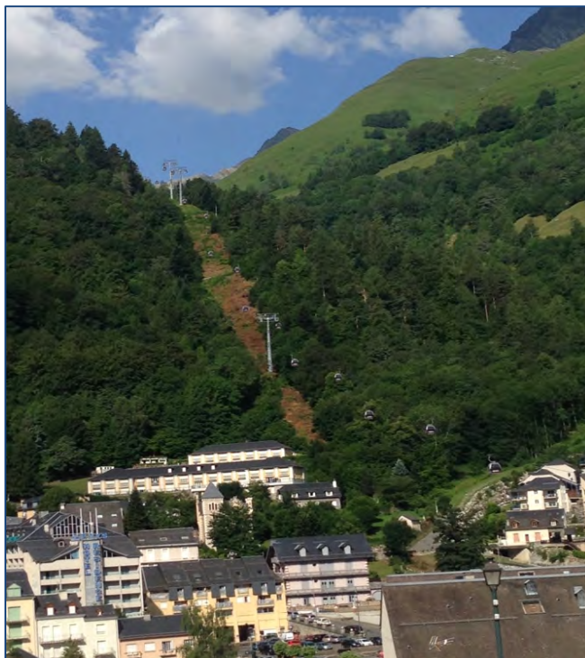
Photo n° 3 : Layon de la télécabine de la station de ski du Lys dans la partie médiane du tracé
