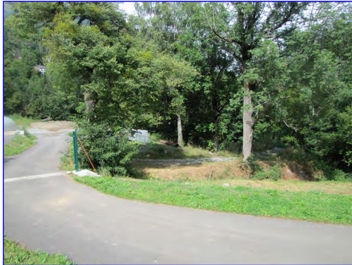
Photo n° 24 : Vue le long du tracé conduite en amont du parking (P13)
