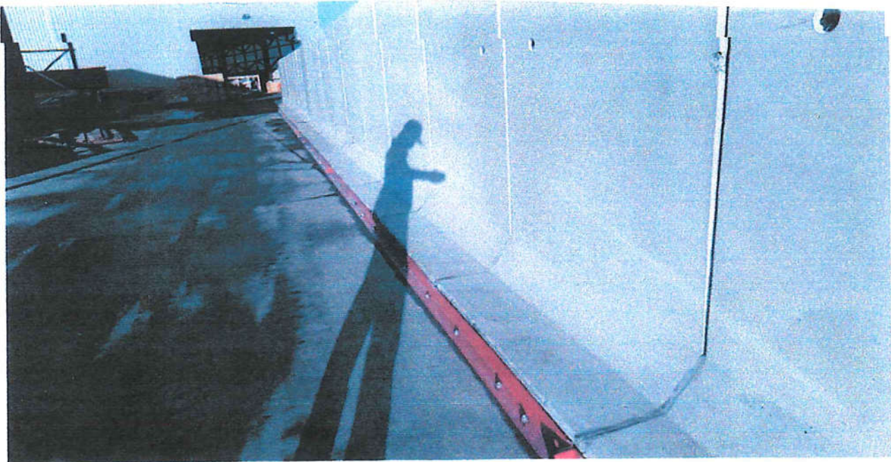
6 - Mur dimensionnaire Nord
