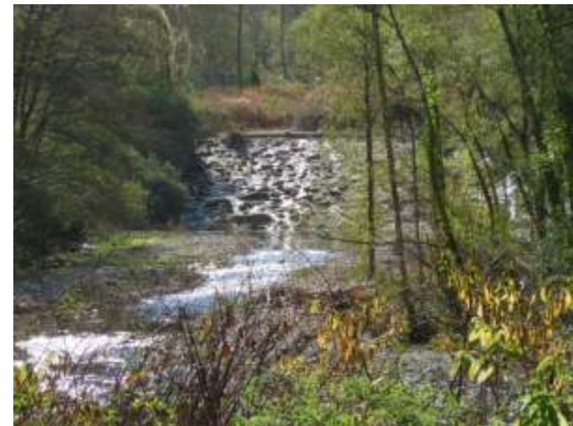
Digue sur l'Adour en amont hydrographique des terrains du projet
