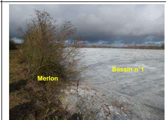
Vue du merlon végétalisé et du bassin n°1
