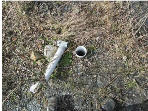
Figure 23 : Vue du piézomètre PZ5 – Digue ouest du bassin n°1
