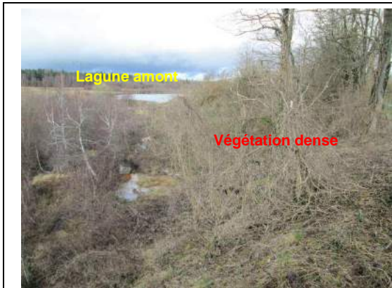
Vue du talus aval recouvert de végétation et la lagune Nord depuis la crête
