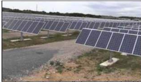
Illustration d'une de nos installations avec longrines béton
