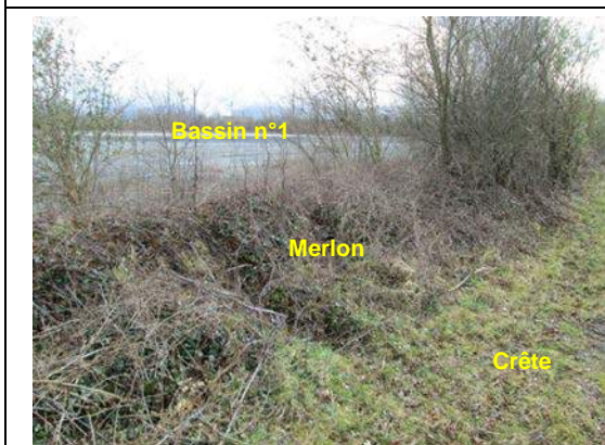
Vue du merlon en crête de digue et du bassin n°1
