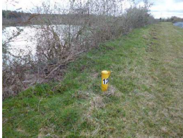
Figure 25 : Vue du piézomètre PZ12 – Digue ouest du bassin n°2
