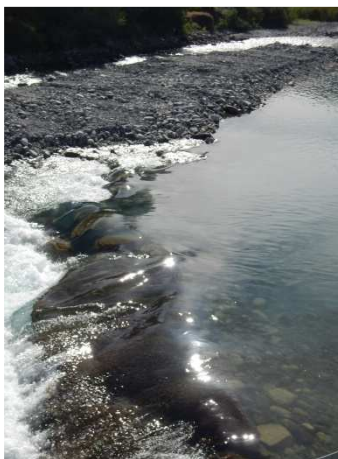
Figure 53 : Seuil aménagé Ferropem
