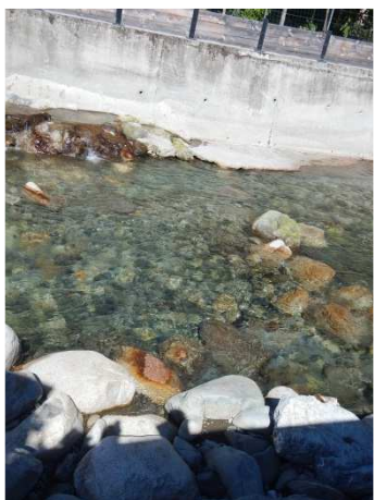
Seuil A arasé
