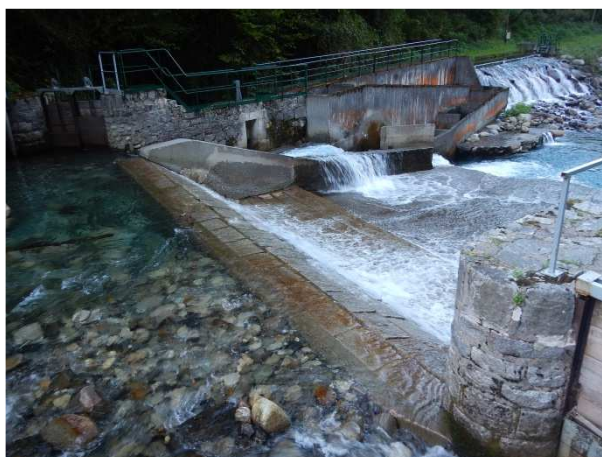
Figure 46 : Seuil Berty maçonné
