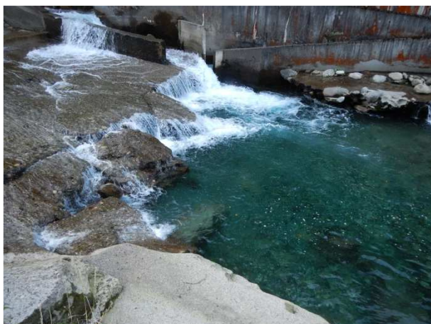
Figure 44 : Fosse d'érosion en pied du seuil
