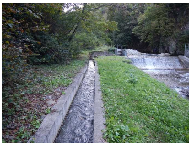
Figure 45 : Prise d'eau et canal d'aménagé en rive droite
