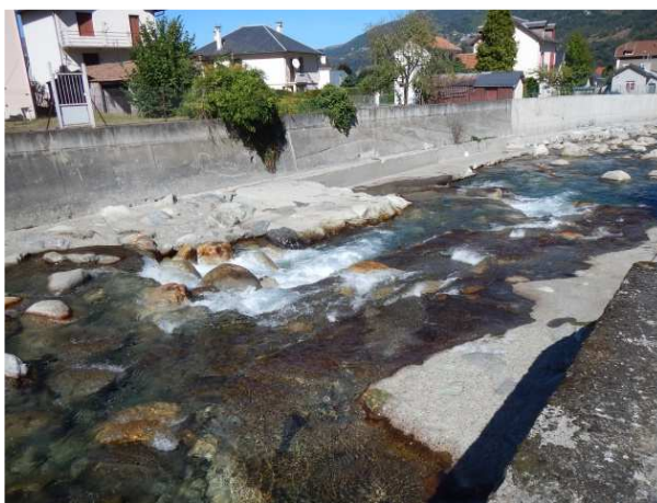
Figure 48 : Seuil E partiellement arasé
