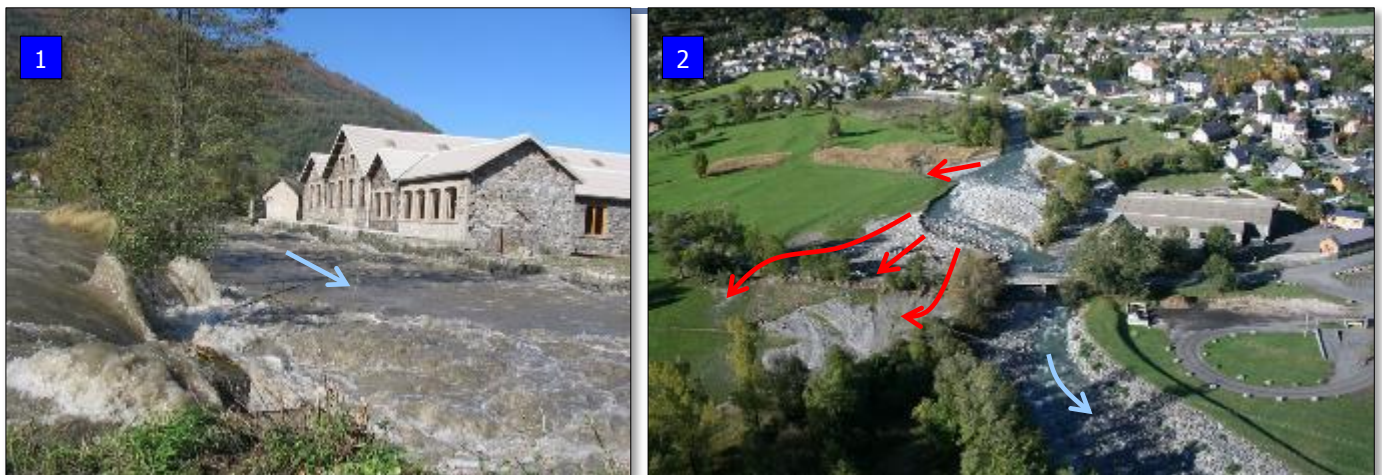
Figure 48 : (1) → Le gave de Cauterets en amont du pont interzone, ayant débordé sur sa rive droite lors de la crue de 2005, photo Hydrétudes ; (2)→ vue du secteur du pont interzone en post-crue 2012, on note les traces de débordements et les accrétions en rive droite en amont du pont, photo CD 65
