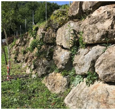
Muret en pierre sèche favorable aux reptiles (secteur n°2)
