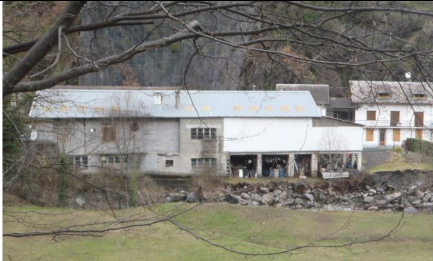
Photo post crues 2012 et 2013
