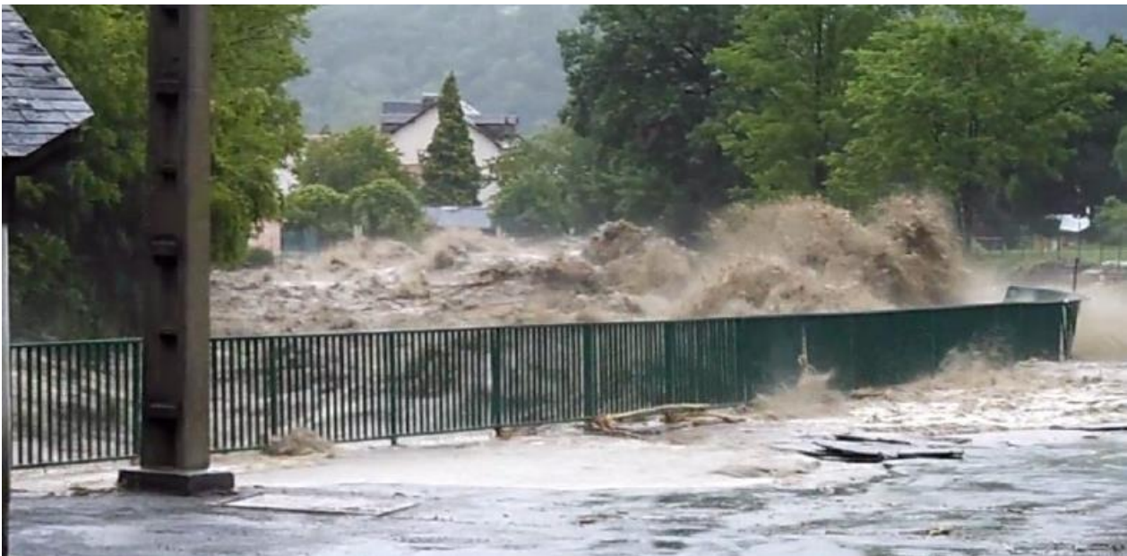
Figure 76 : Vue de la violence des surverses pour une faible hauteur déversante sur l'ouvrage (présence accrue de vagues et fortes vitesses sur la route)
