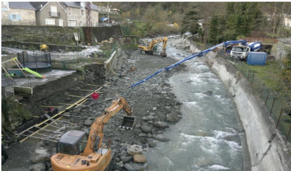
Figure 95 : Reconstruction du tronçon GC 35.3 (compte rendu chantier RTM du 04/12/2013)
