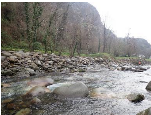
Figure 97 Famille 2.6 : ouvrage sans aucune protection – tronçon GC 29.1
