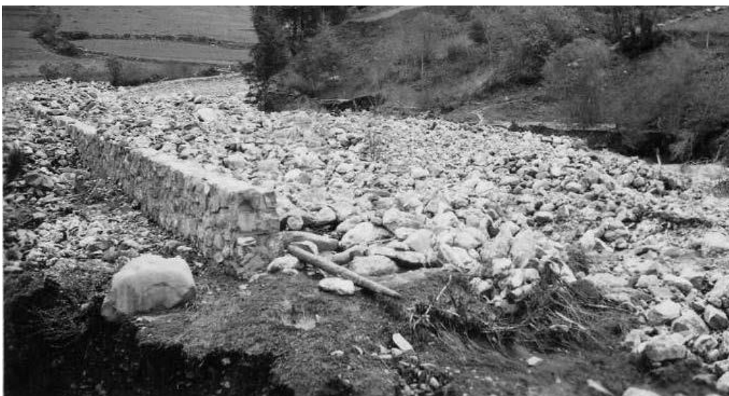
Figure 59 : Surverse sans rupture suite à l'engravement du lit - Chagnon - Vars (05) – 1957
