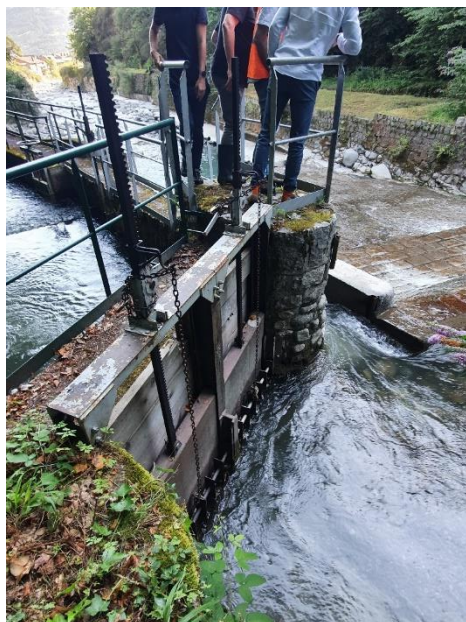
Figure 28 : Vanne amont (à gauche) et module à masque (à droite)
