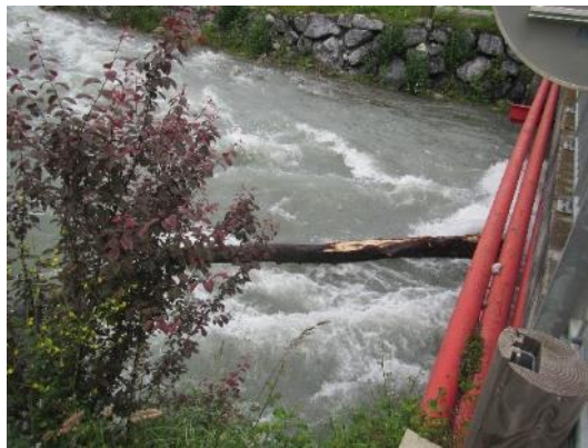
Figure 42 : Embâcle sur le pont interzone lors de la crue de juin 2018 (PLVG)
