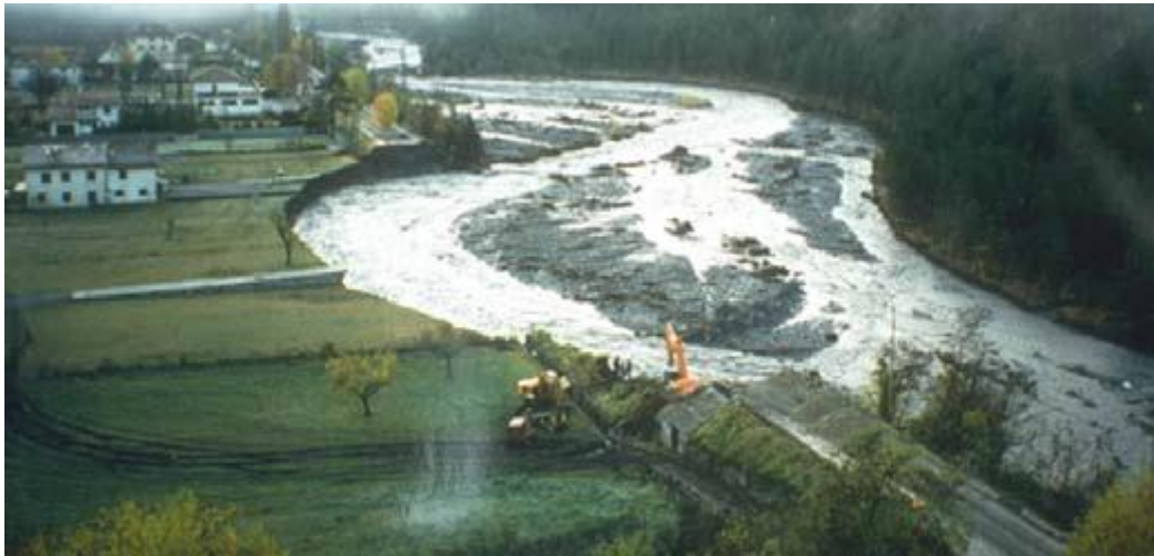
Figure 56 : mobilité fluviale du Var ayant "emporté" un linéaire de la digue de Guillaumes (source : ONF Alpes Maritimes)
