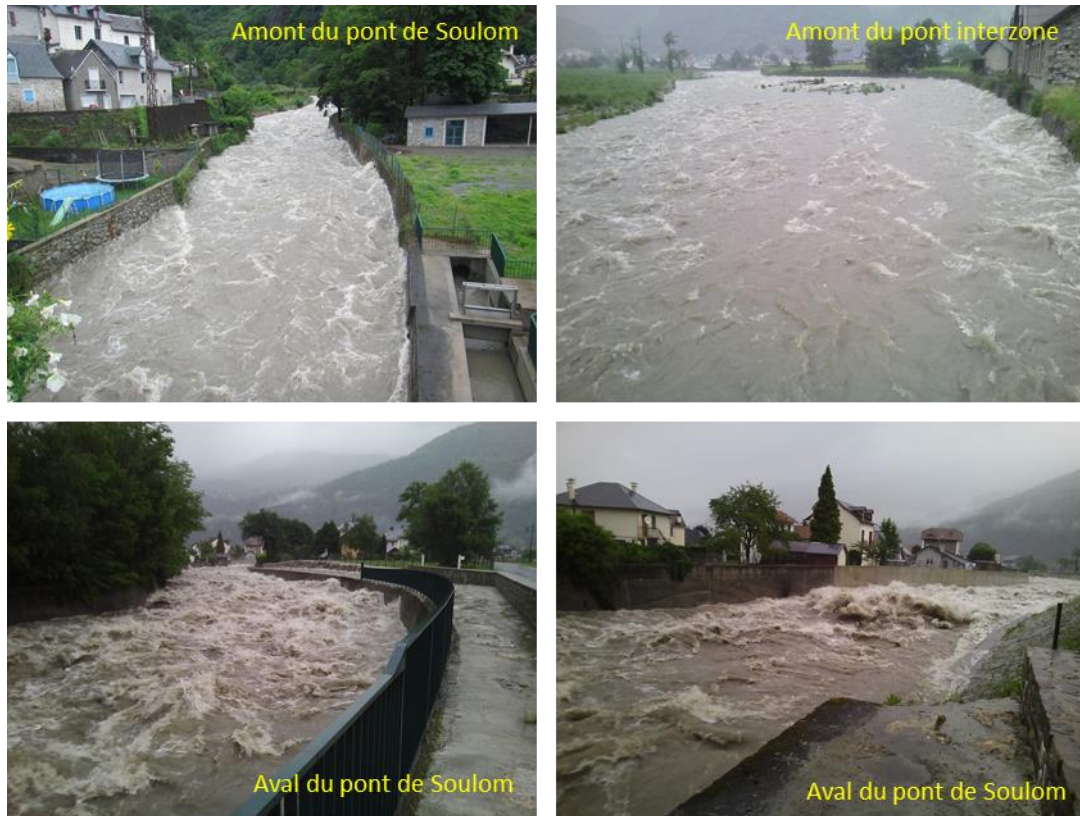
Figure 41 : Crue de juin 2018 sur le système d'endiguement de Pierrefitte-Nestales (PLVG)
