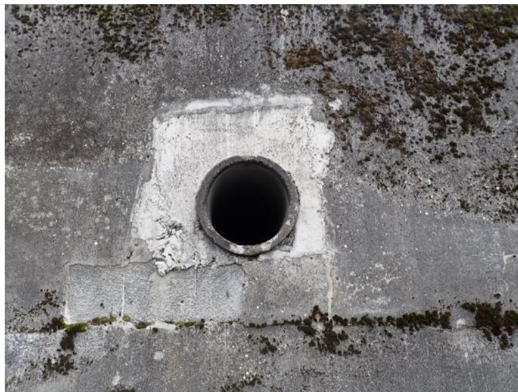
Figure 38 : Ouvrage traversant de diamètre 500 mm du tronçon GC 36.3
