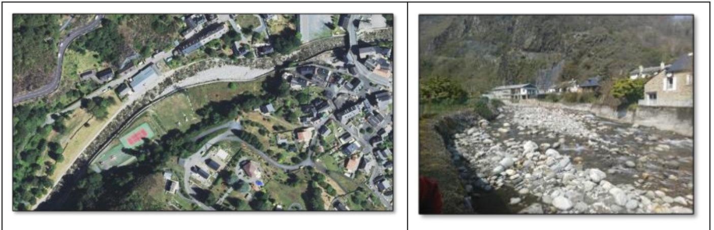
Figure 15 : exemple de secteur d'engrassement (zone A) en amont du pont de Soulom
