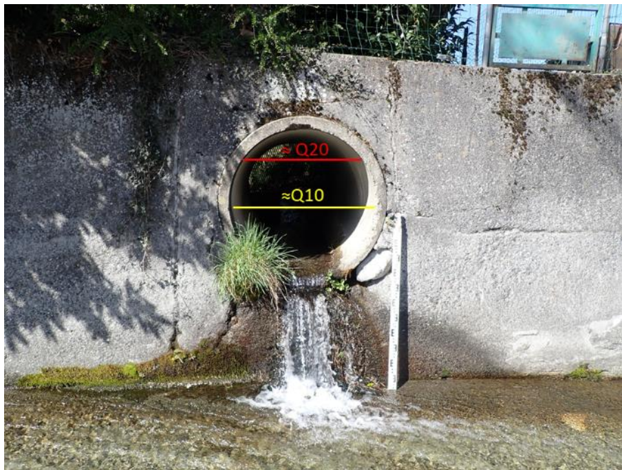
Figure 35 : Ouvrage traversant de diamètre 1000 mm du tronçon GC 40.4 et niveaux approximatifs des crues Q10 et Q20
