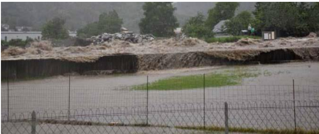
Figure 60 : Surverse sur la digue - Gave de Cauterets - Pierrefitte Nestalas - Juin 2013 (source SMDRA)
