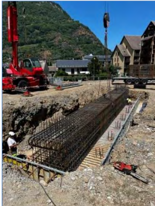
Photo n° 13 : Exemple d'une semelle en cours de ferrailage et de coffrage
