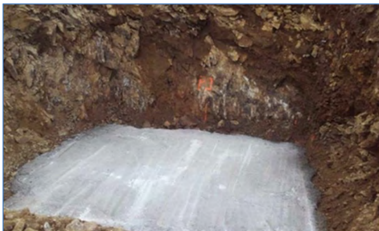
Photo n° 12 : Exemple d'une béton de propreté en fond de fouille
