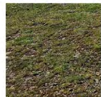
04 - Toiture terrasse revégétalisées avec espèces endémiques sélectionnées
