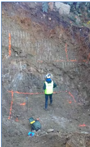
Photo n° 11 : Contrôle des fouilles par un géotechnicien
