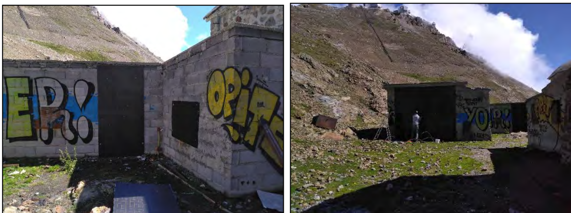
Photo n° 14 : Calfeutrage des entrées du bâtiment
