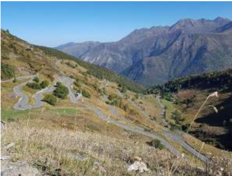
Route d'accès à la station de Luz- Ardiden
