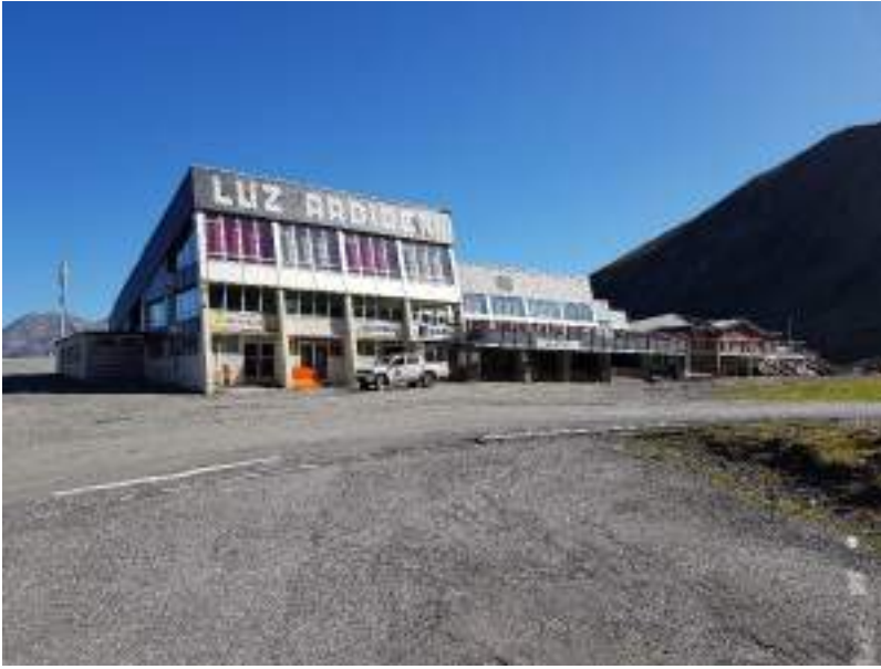
Station de Luz-Ardiden : bâtiment d'accueil du secteur principal (Aulian)
