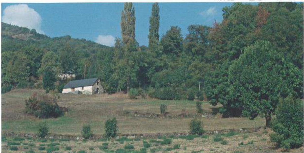
① Murets de soutènement de près de façade quartier de Courrèges
