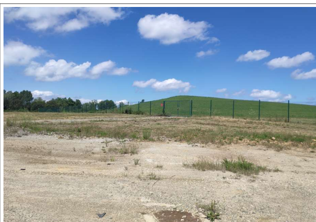
3 : Vue sur la zone de stockage de terres impactées au nord-ouest du site
