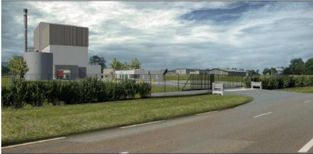
Photo après travaux
