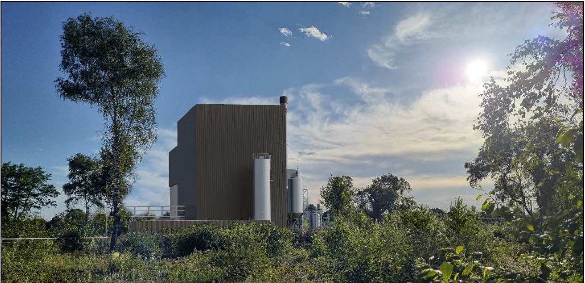
Figure 12 : Photo 2 – avant et après travaux
