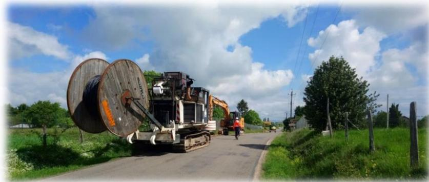
Exemple de chantier d'enfouissement de câble le long d'une voirie (source : sciepd)
