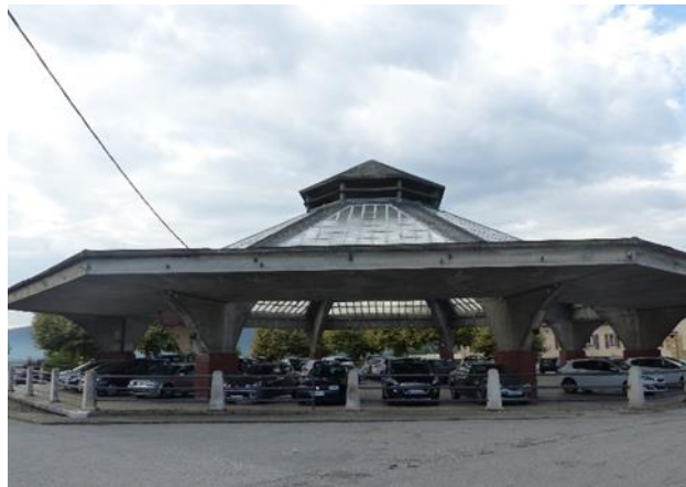
Halle place de Verdun (© Cabinet ECTARE)
