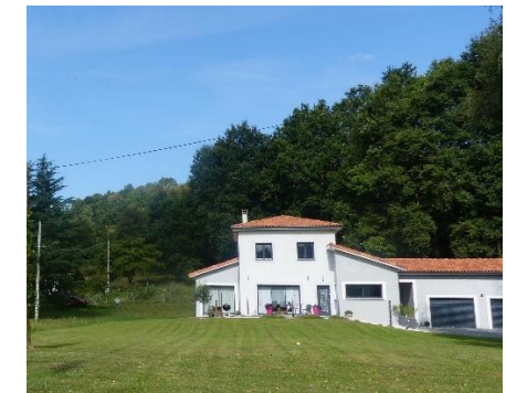
Logement caractéristique du secteur d'étude, Mazères-de-Neste (© Cabinet ECTARE)
