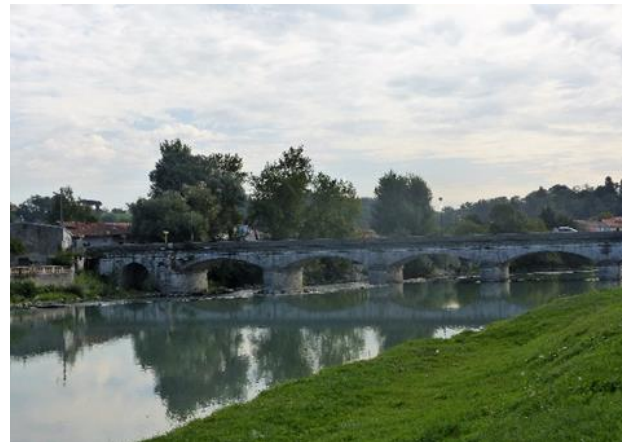
Pont de la RN125 (© Cabinet ECTARE)
