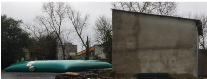
Figure N° 14 : Réserve incendie et local d'équarrissage
