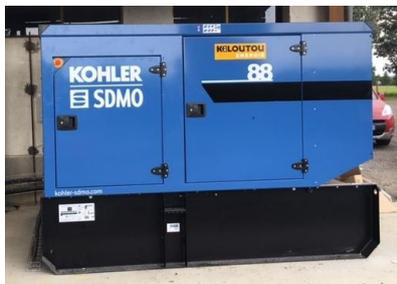
Figure N° 13 : groupe électrogène
