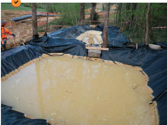
Dispositif de surverse à gabion de paille.
