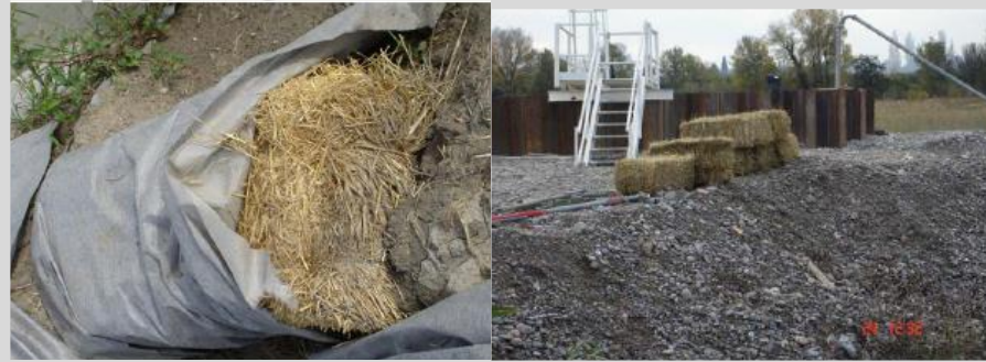
Figure 16 : Filtres à pailles
