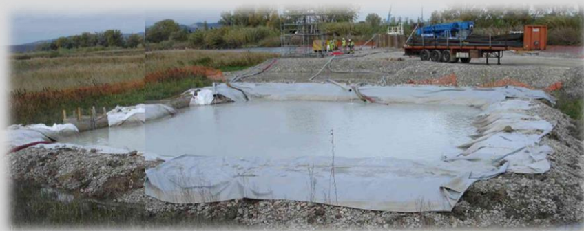
Figure 17 : Bassin provisoire de décantation des MES et autres polluants
