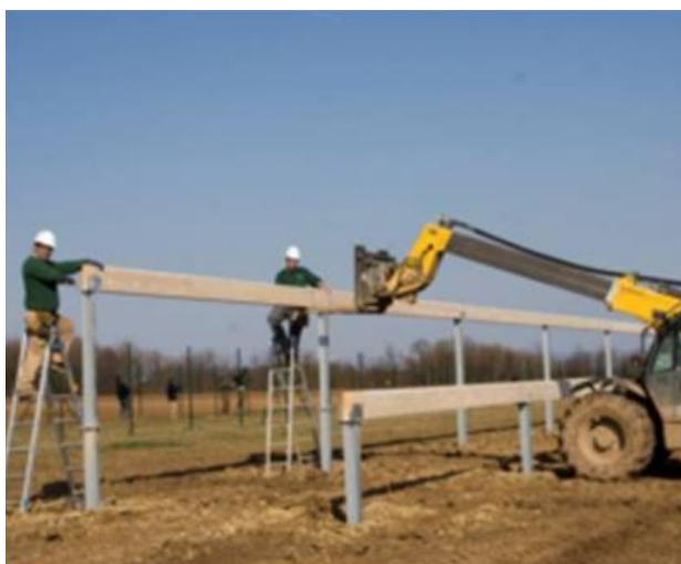
Figure 77 : Montage des structures porteuses
