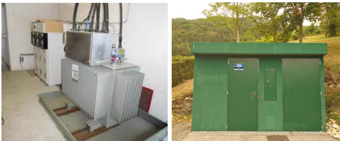
Figure 71 : Exemple d'un poste de transformation
