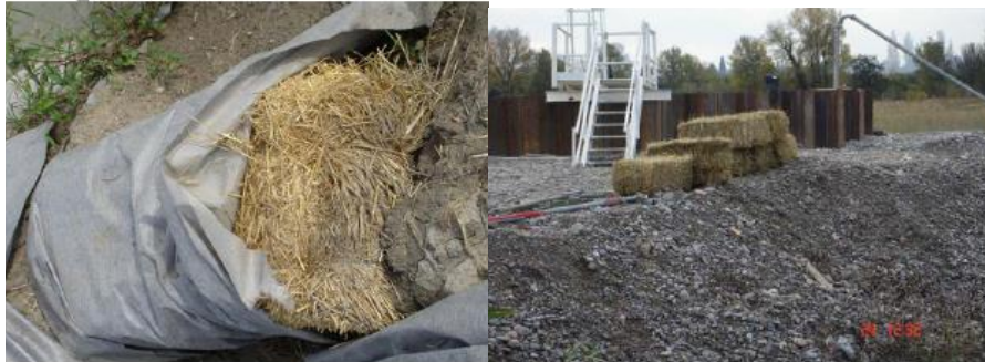
Figure 115 : Filtres à pailles (Source photo : CETE)
