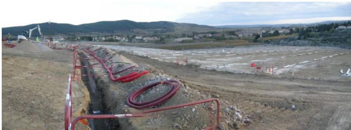
Figure 76 : Travaux de création d'une tranchée
