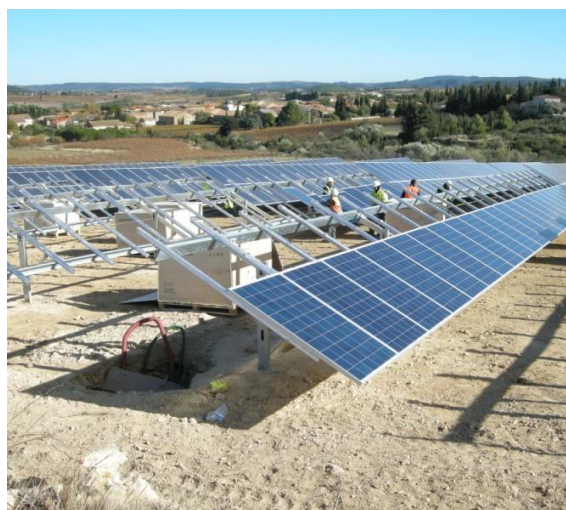
Figure 78 : Montage des modules
