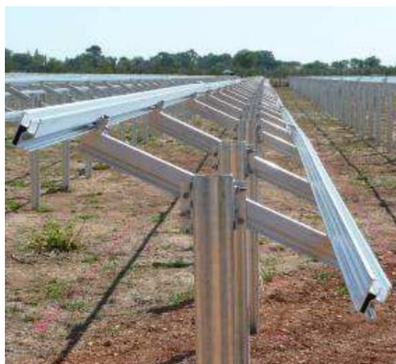
Figure 68 : Exemple de pieux battus
