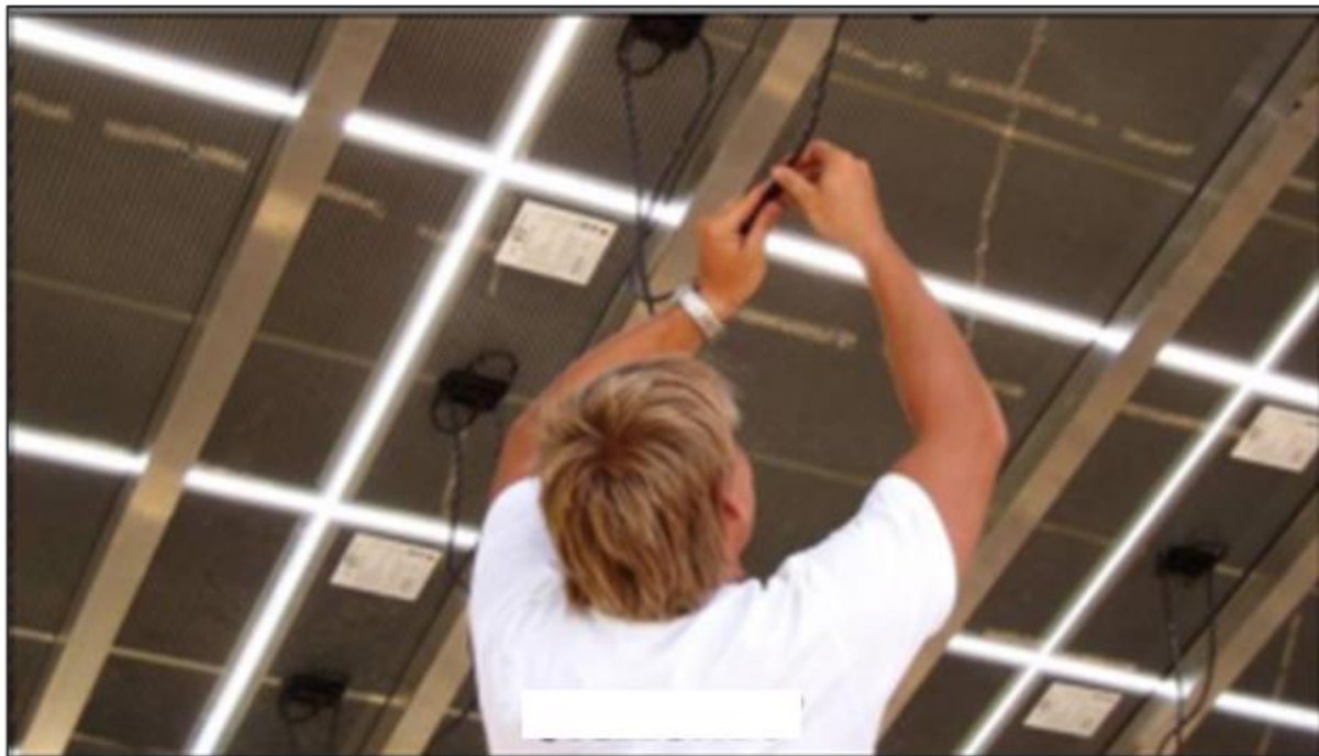
Figure 82 : Vues des interstices de 2 cm entre chaque panneau
