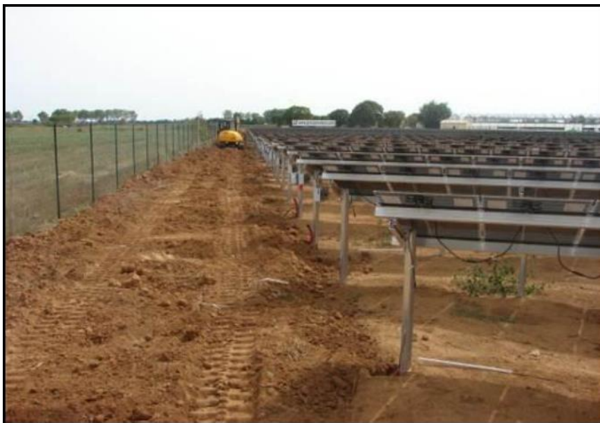
Figure 108 : Recouvrement des tranchées
