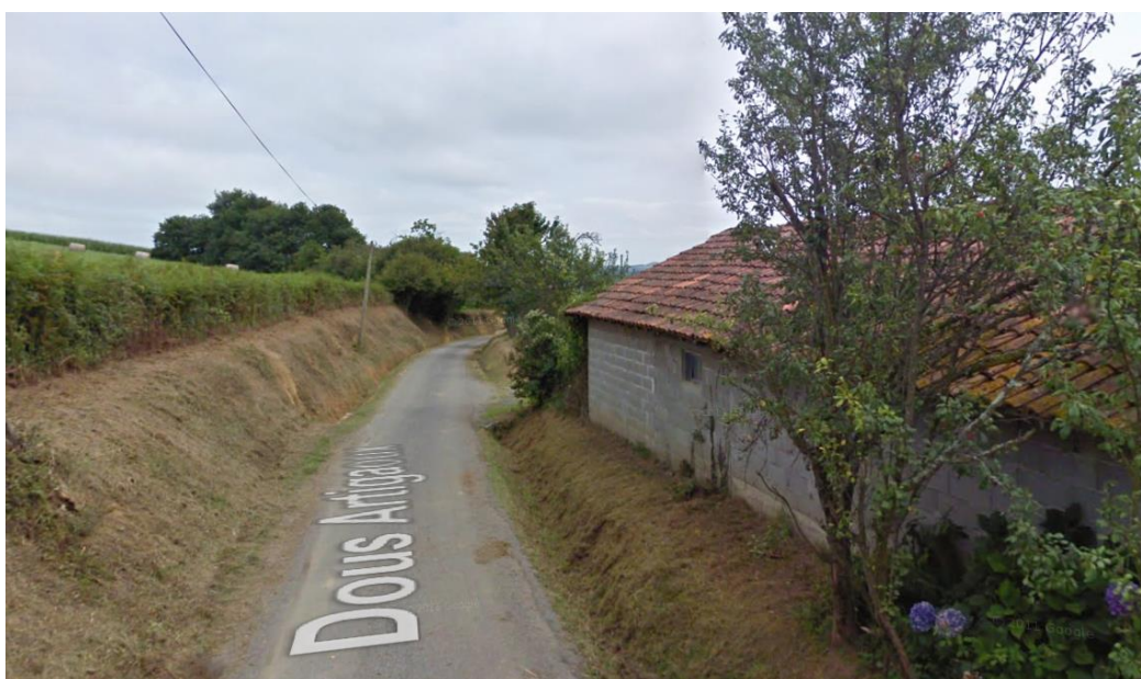
Figure 56 : Vue sur la voie communale menant au site du projet (Source : Google maps)
