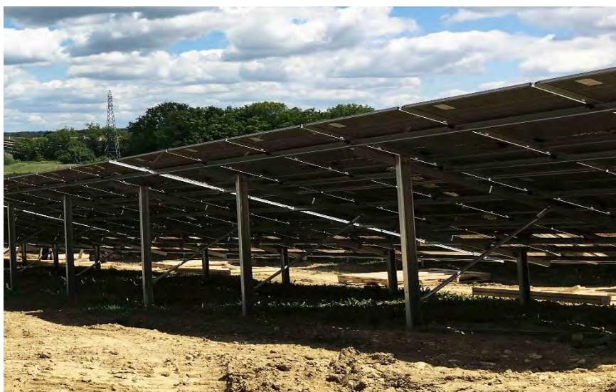
EXEMPLE DE REALISATION AVEC PIEUX BATTUS
