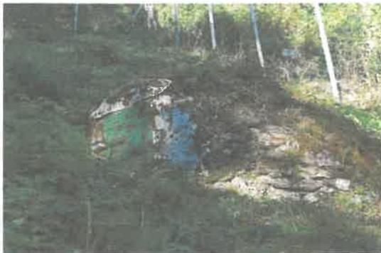
L'ouvrage de captage date des années 1950. Il se présente comme un dôme maçonné dont la face intérieure en béton semble en état.
