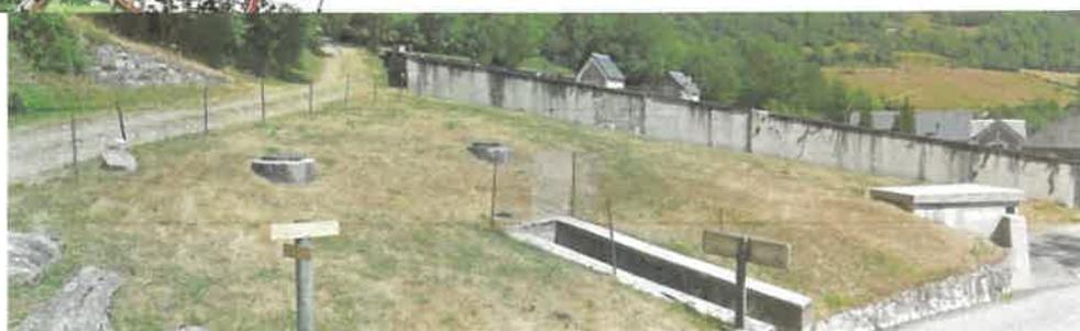
Les réservoirs totalisent un volume 100 m3 avant d'alimenter le village. Chaque secteur de distribution est équipé d'un compteur général qui permet de connaître les volumes mis dans le réseau. réseau de distribution (hors branchements) estimé à 3 460 ml.
