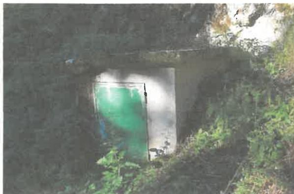
L'ouvrage du captage est un abri bétonné adossé à la paroi rocheuse d'où arrive l'eau à travers une fissure. La dalle supérieure est endommagée sur un angle.
