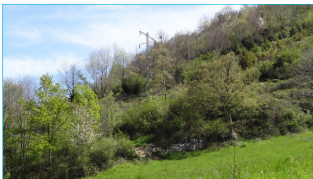
Le pylône de la ligne existante dans la zone humide
