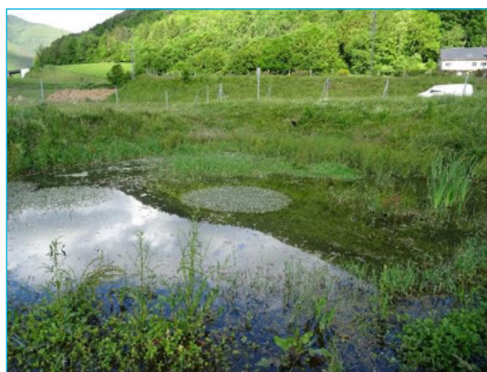
Bassin d'eau pluviale à Arreau (photo IEA)
