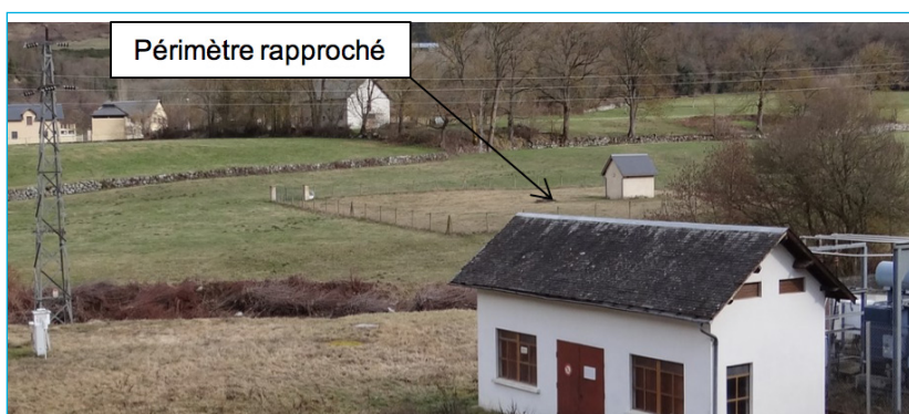
Le captage du Puits des Espeyoudes
