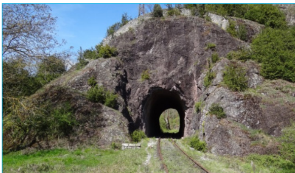
Le tunnel à l'amont de Camous
