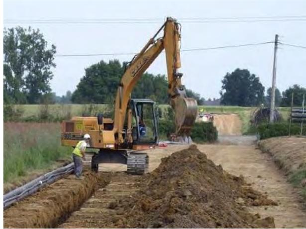
*Ouverture d'une tranchée (à droite la terre végétale en cordon) en terrain agricole*
