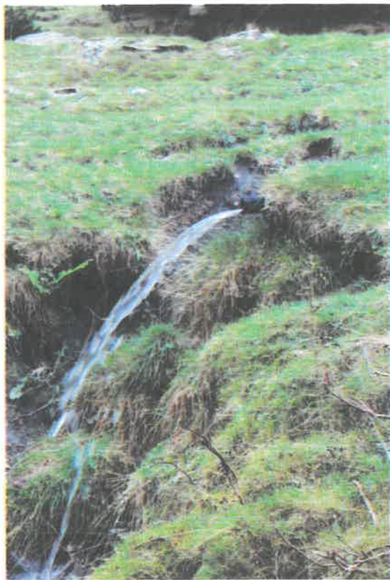
Trop-plein du brise-charge (réservoir)
