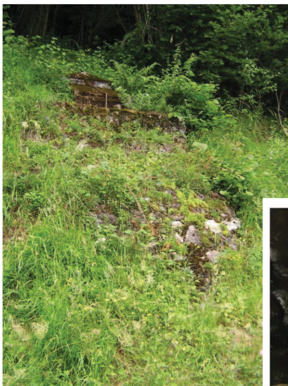
Figure 2-16 : Matrasse, à gauche : brise-charge en bordure de la RD et à droite : brise-charge, problème d'étanchéité sur le capot
