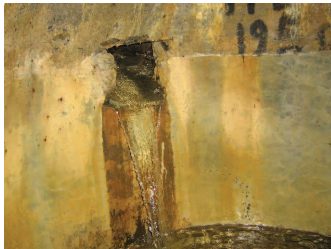
Figure 2-14 : Matrasse – Arrivée du Griffon
