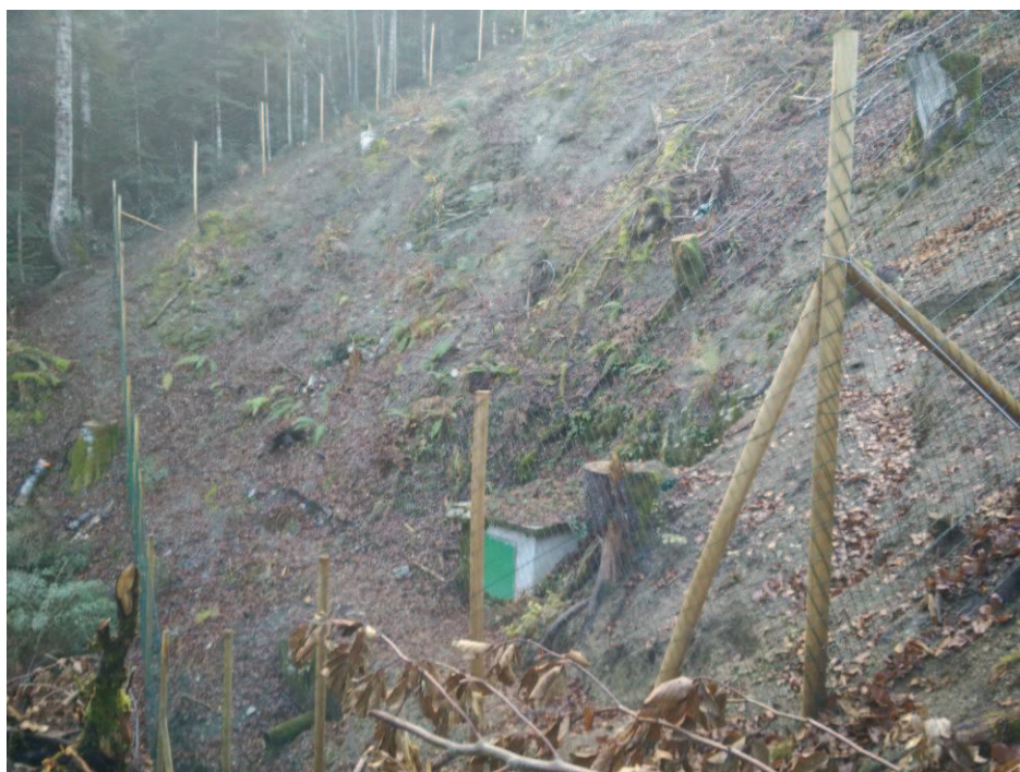
Figure 2-23 : Hount des Panets - Environnement immédiat du captage (2016)
