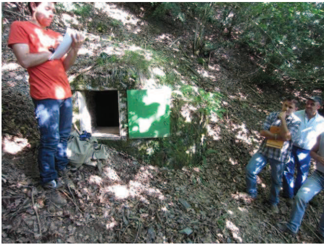
Ouvrage de captage de la source de Matrasse
