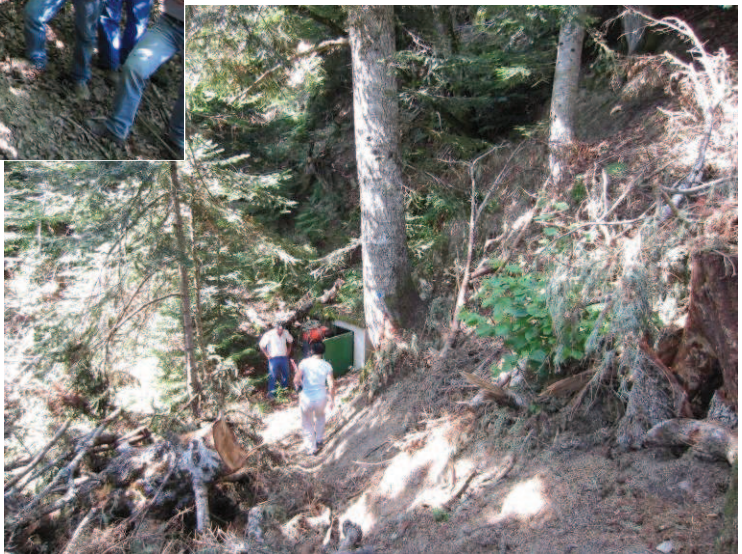
Contexte de l'ouvrage de captage de la source dite « Hount des Panets »
