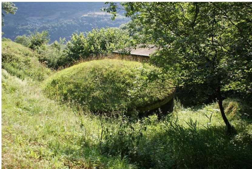
Réservoir de 120m3
