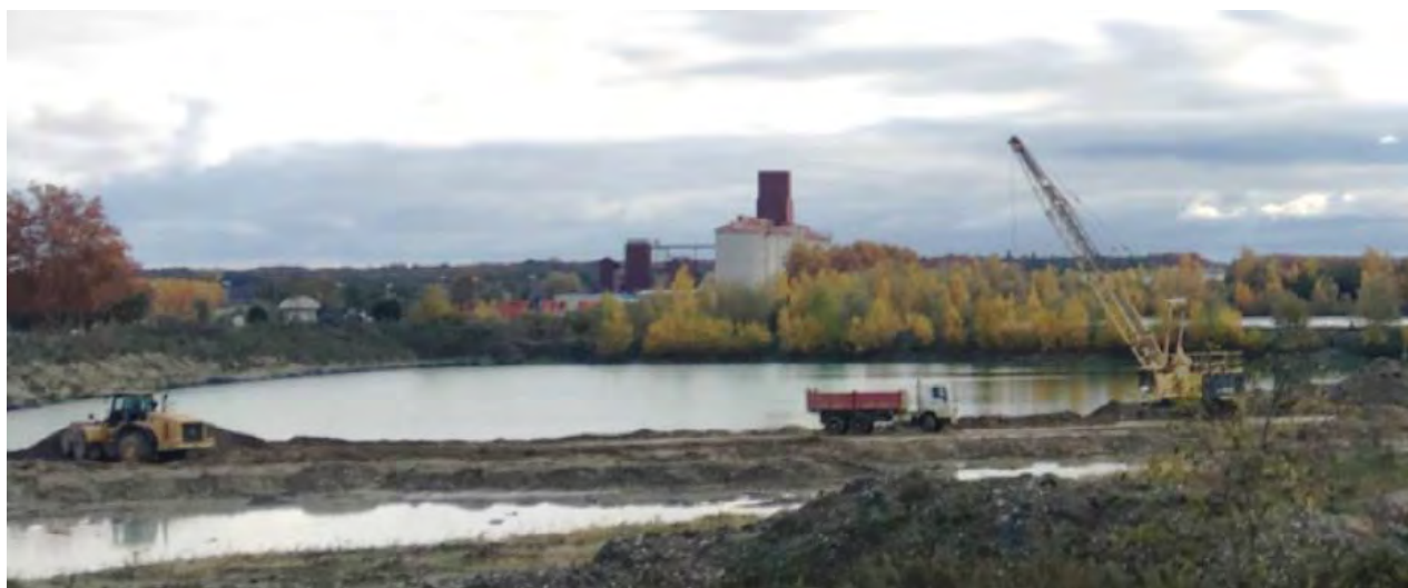
Carrière en cours d'exploitation
