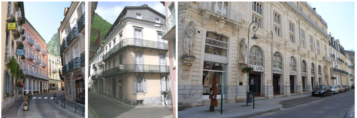
Les maisons de du temps des attelages à chevaux RDC ( souvent ouvert de larges devantures commerciales) + 1 à 3 étages + comble aménagé de lucarnes.
