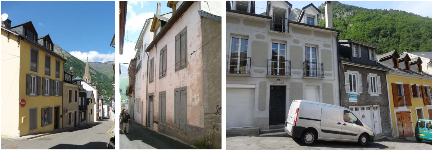
Les maisons de la Villette : RDC + 1 étage + combles percé de lucarnes, ouvertures protégées par des contrevents en bois.
