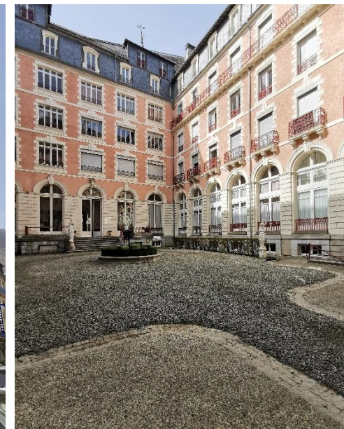
Façades sur cour ordonnancées
