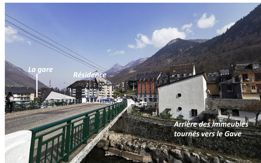
B. Vue depuis le pont sur le Gave vers la gare et son bâti environnant
