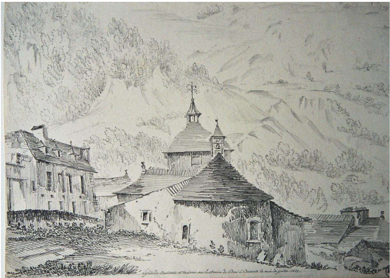
« Eglise de Cauterets et maison sur le chemin de Pose à Cauterets, le mois de Juillet 1822 » Dessin original NATTES Coll. Musée Pyrénéen, Lourdes
