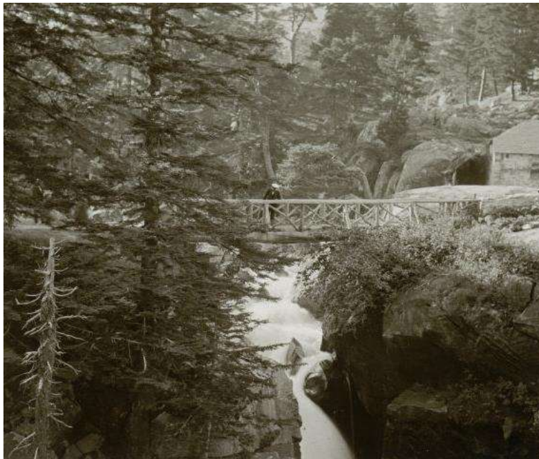
Pont d'Espagne Source du document : site « GALLICA » Pont bois, Photographie Lestranges, source du document : site « GALLICA »
