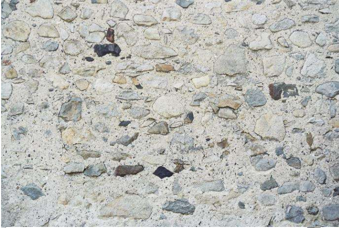
Enduit de chaux et sable à pierre rase sur maçonnerie de petits moellons
