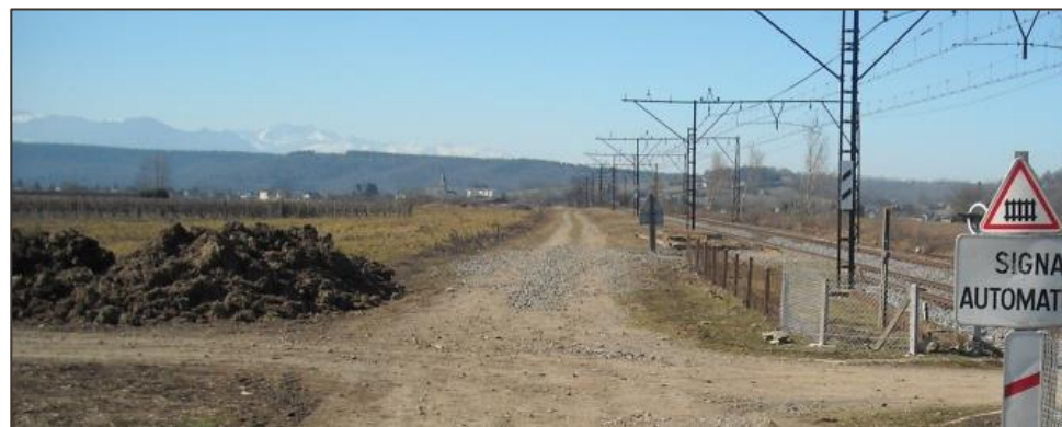
Vue du chemin latéral à la voie ferrée depuis le PN 171
