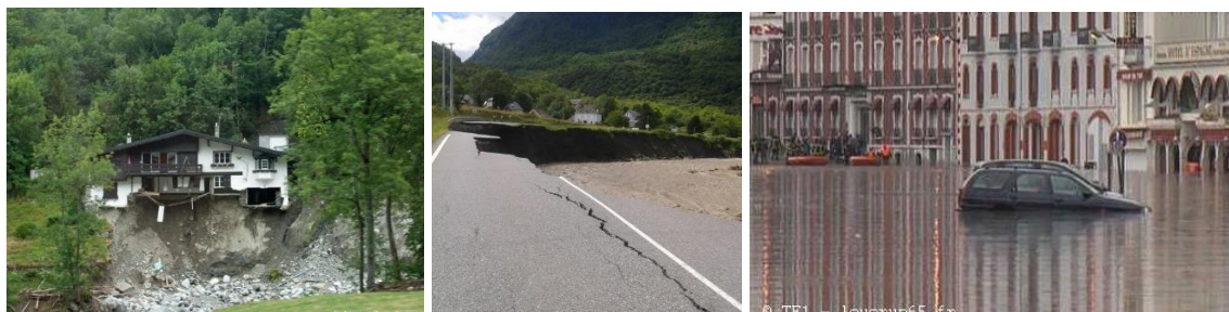
Crues 2013 - Maisons emportées, routes arrachées et des centaines de millions de dégâts.
