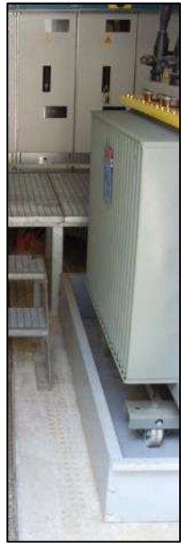
Vue du bac de rétention sous transformateur
