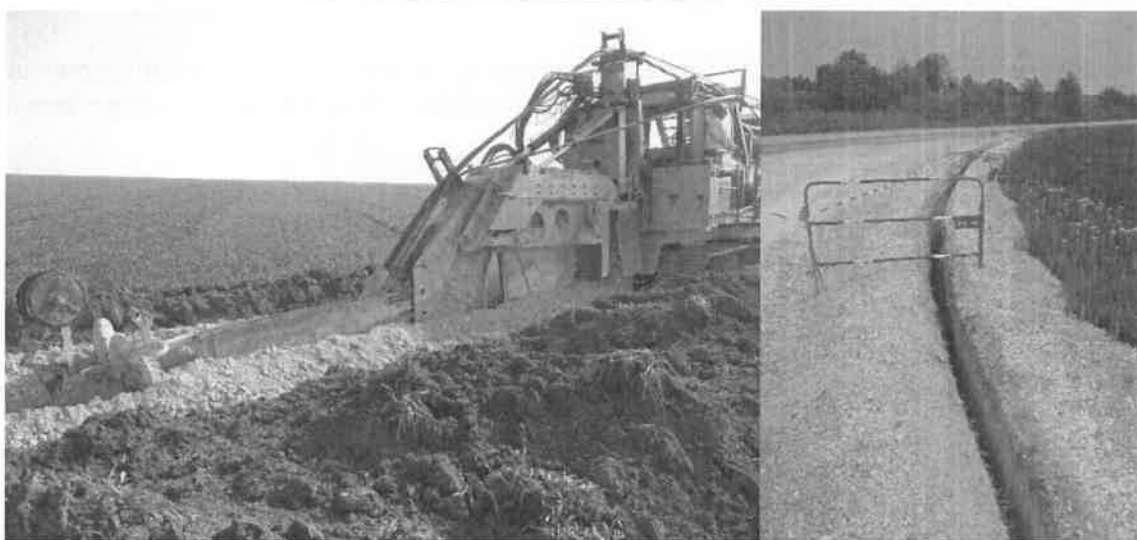
Figure : Exemple de tranchée réalisée (Source : Total Quadran)
