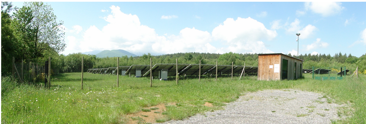
Vue de la centrale solaire en fonctionnement, au nord-est du projet
