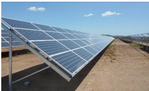
Exemple d'implantation de tables photovoltaïques
