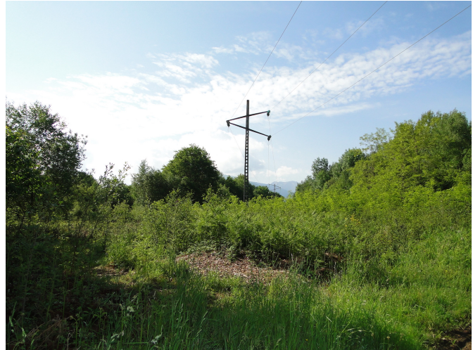
Ligne électrique traversant la zone-projet
