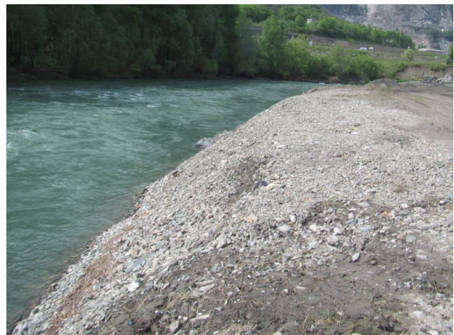
Exemple de réinjection de matériaux (PLVG)
