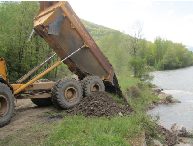
Exemple de réinjection de matériaux (PLVG)
