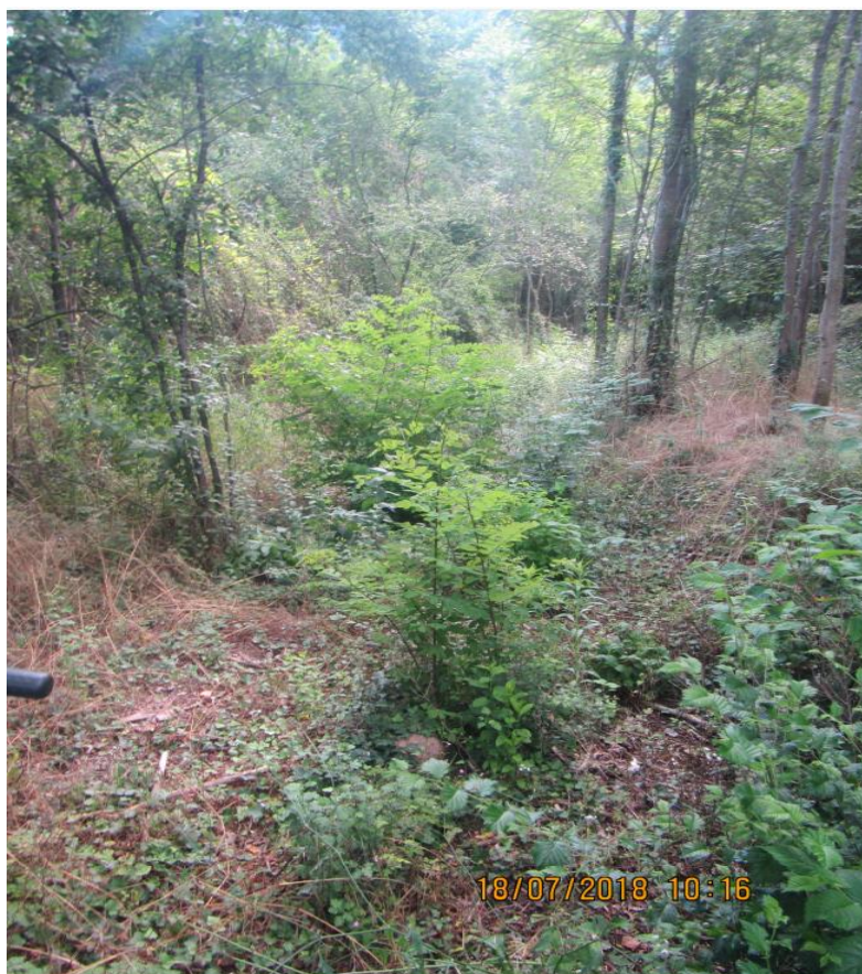
Intérieur du chenal à reprofiler
