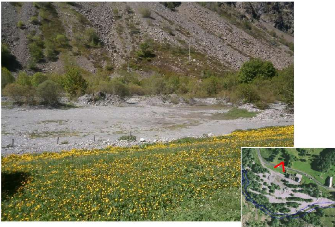
Figure 13- Vue du site depuis la RD 922
