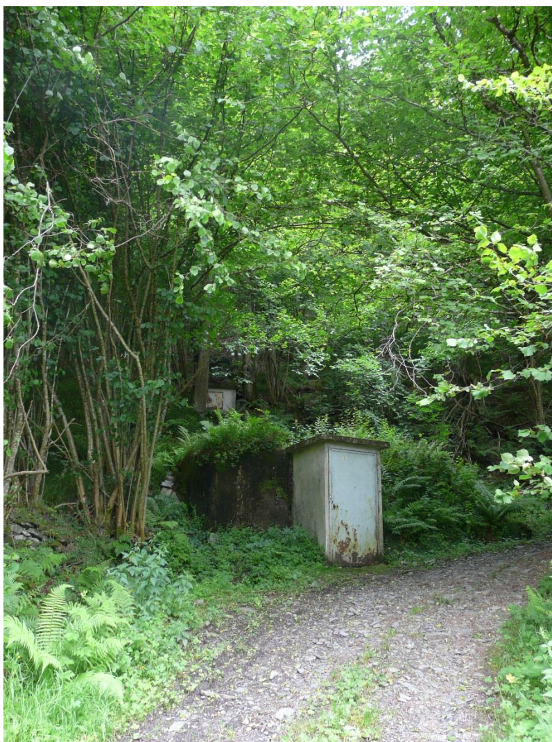
Captage et réservoir de la source d'Aranou – 26 juin 2020
