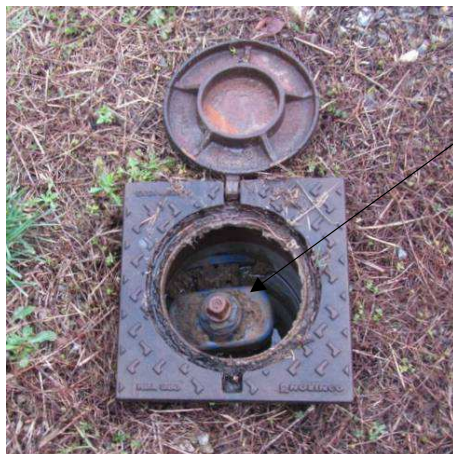
Robinet-vanne avec carré 30x30 sous tampon
