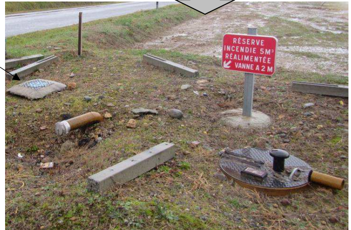
Robinet-vanne avec carré 30x30 sous tampon
