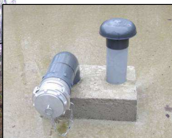
Raccord AR de remplissage
