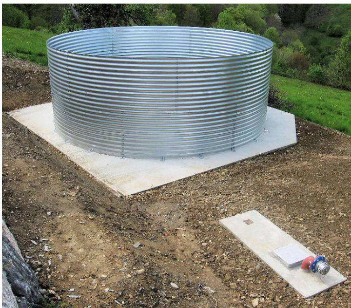
Réserve silo en construction avec prise déportée (en esse) avec vanne de barrage et système de purge
