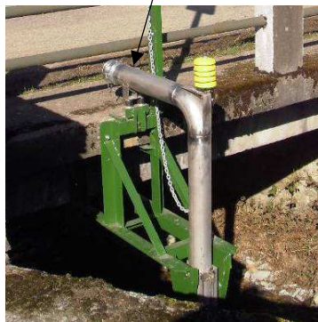
Colonne relevée, posée sur berceau
