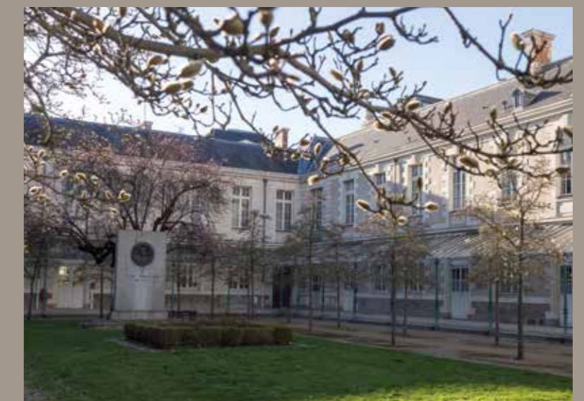
Lycée Clemenceau, Nantes
