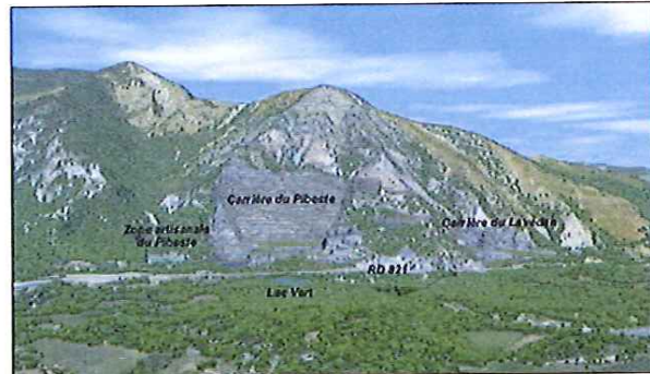
Vue éloignée du site réaménagé depuis l'Est
