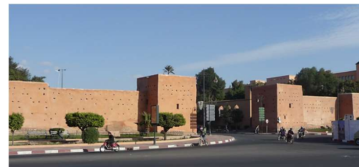
Murs d'enceintes de Marrakech en pisé identifiable par ses trous de banchage en quinconce (XII ème s.)
