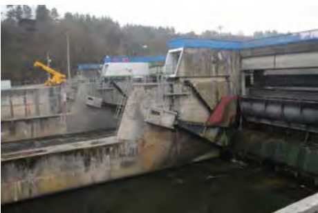
Exemple de barrage - Villey-le-Sec (54)
