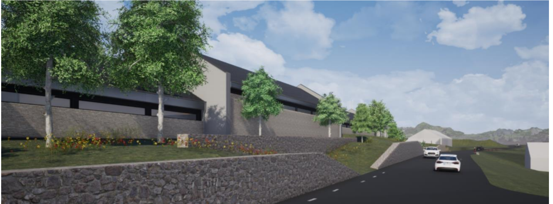
Vue vers l'entrée du poste d'Aure
